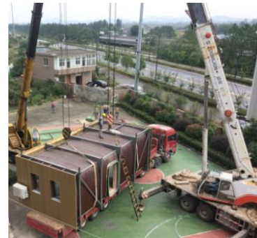
房屋组装 House Construction
