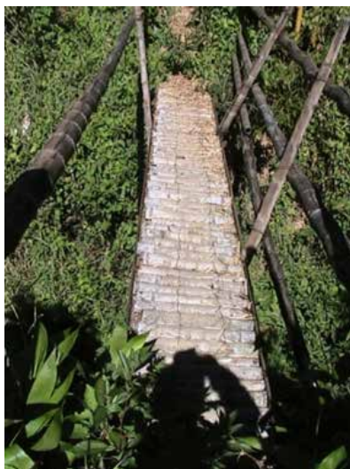
Figura N° 10. Puente peatonal elaborado con cañas partidas de bambú
