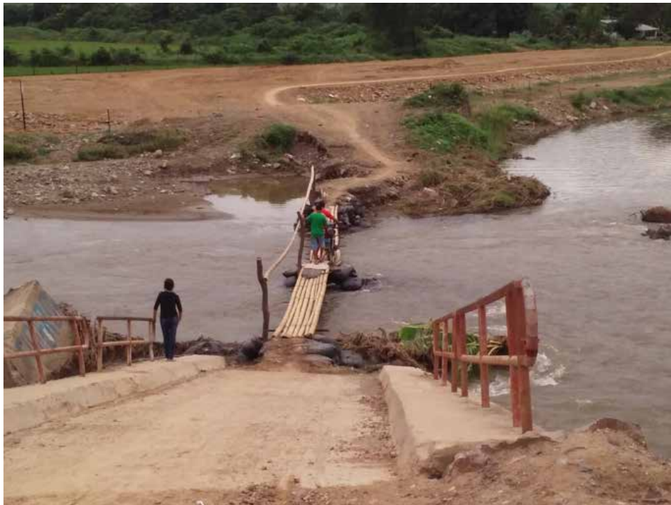
Figura N° 18. Puente peatonal de emergencia construido con bambú
