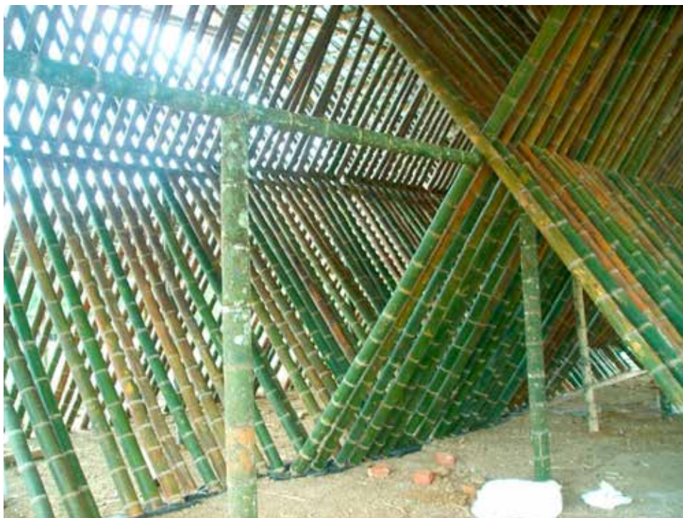
Figura N° 16. Secado al aire en tijerales
