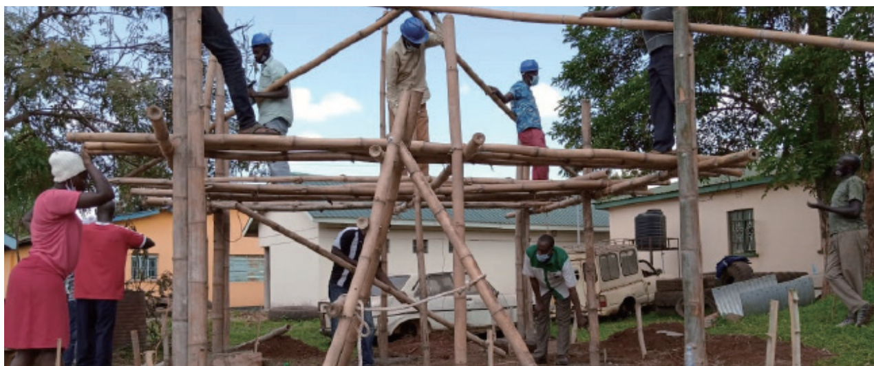
Construction d'un kiosque dans le comté de Busia au Kenya dans le cadre du programme Chine - Pays-Bas - Afrique de l'Est.
