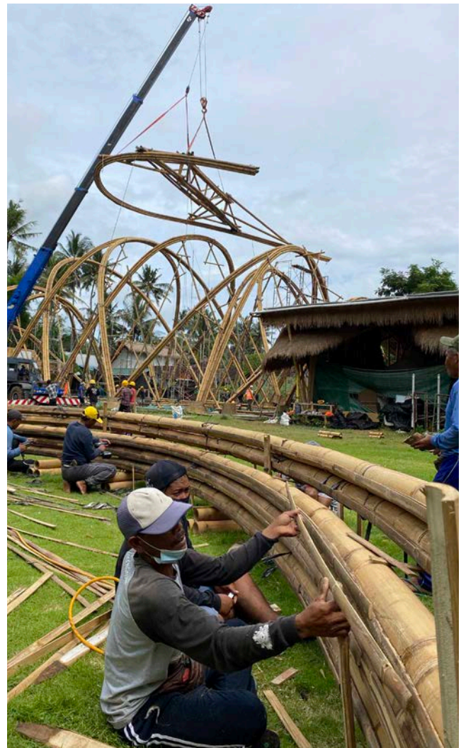
Une grue positionne une arche de L'Arc à la Green School, Bali. Crédit : Elora Hardy
