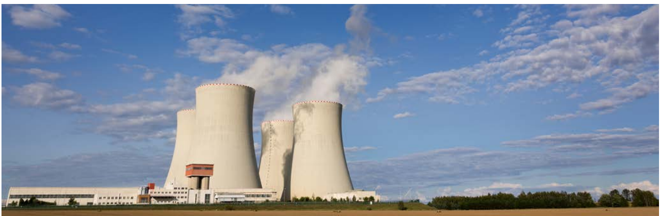
Au cours des dernières décennies, les tours de refroidissement des centrales électriques ont été presque exclusivement revêtues de packing en PVC.
