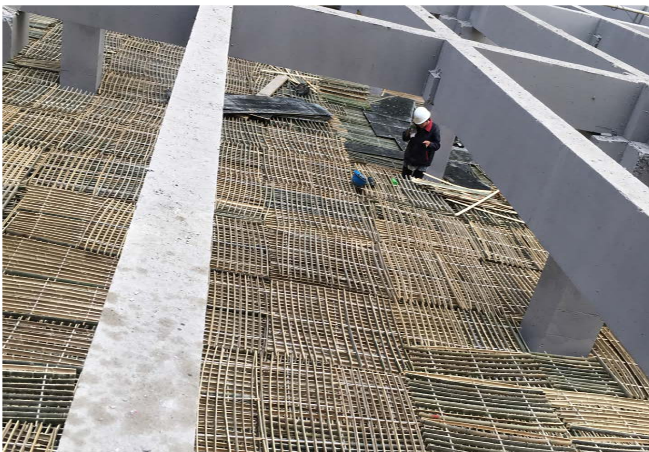
Installation du packing en grilles de bambou à la centrale électrique de Dongfeng, l'une des 80 entreprises en Chine à utiliser cet équipement. Crédit : Ma Xinxin et al.
