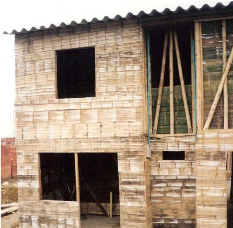
Gauche : Des lattes de bambou fendues clouées sur des cadres en bambou à « Bambusa » en Colombie : c'est le premier projet de logements à être conçu conformément au chapitre E.7. Architecte : Jaime Mogollón ; Ingénieur : Samuel D. Prieto. Droite : Une maison bahareque d'ingénierie sur un simulateur sismique à l'université de Los Andes. Ses performances sismiques sont excellentes. Crédit : David Trujillo.
