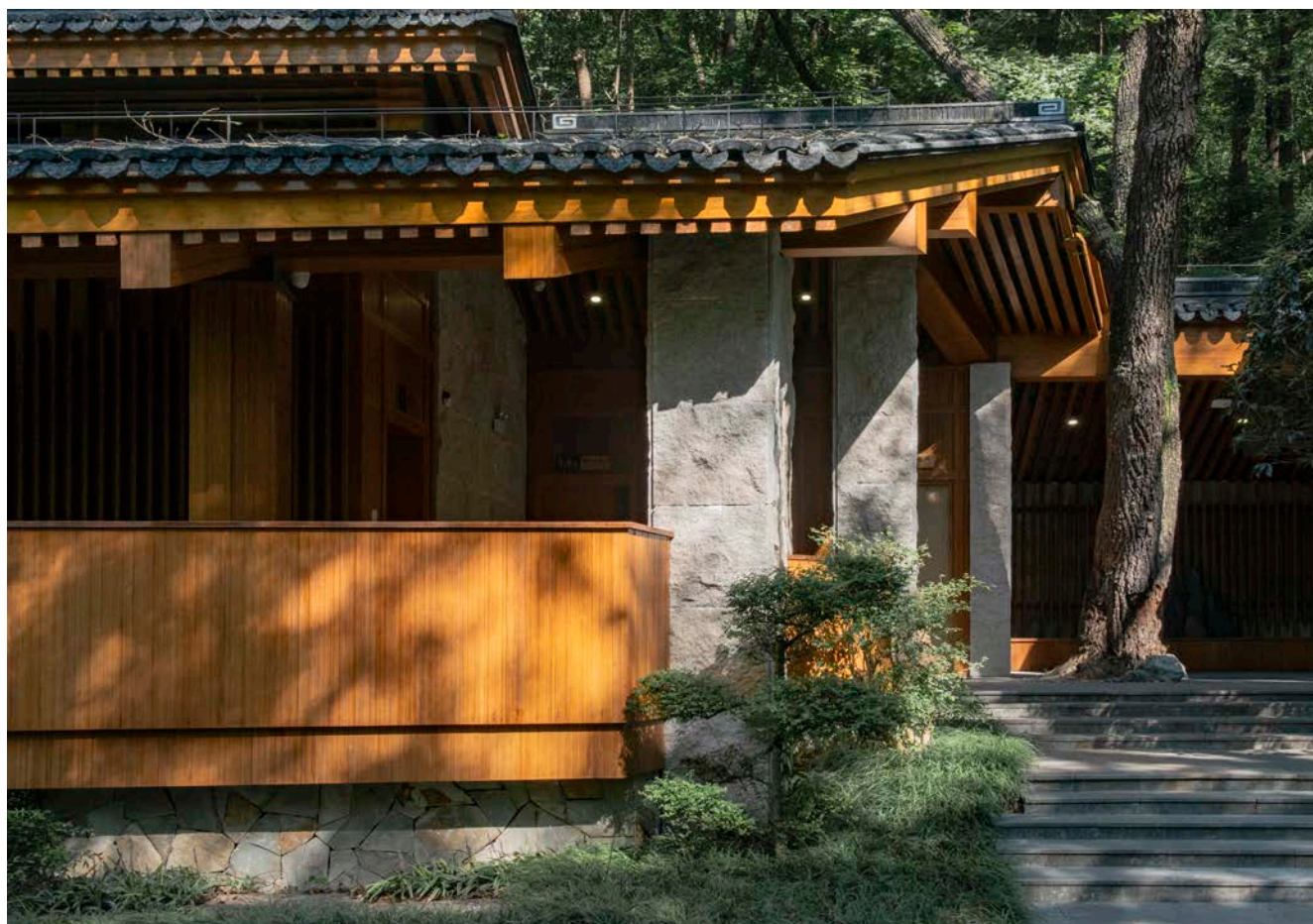
Station touristique de Qixia. En tant que projet antérieur d'ATA Studios, le bambou est ici principalement décoratif et non structurel. Crédit : Timeraw Studio
