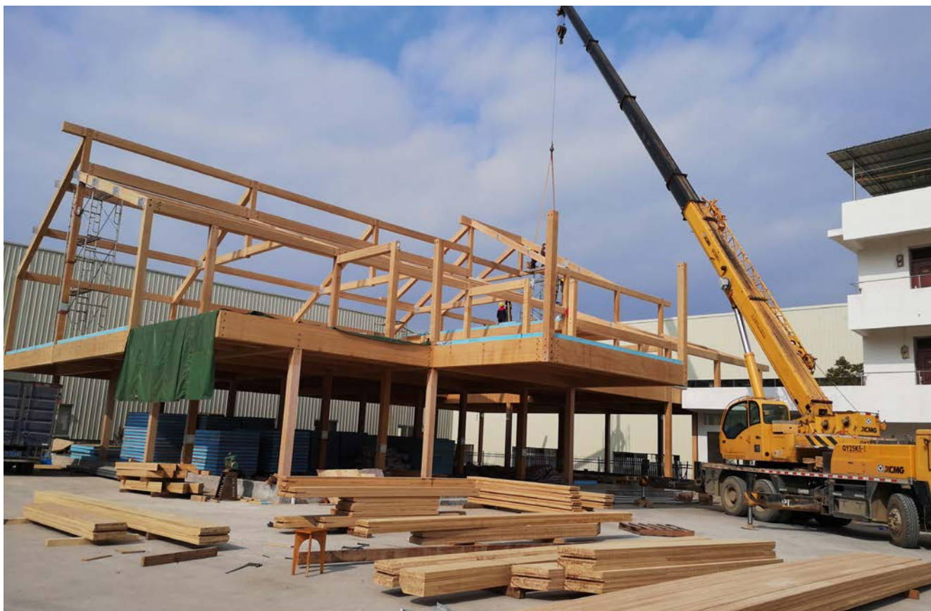
Construction d'un immeuble de deux étages en bambou lamellé-collé en Chine. Le bambou est un choix traditionnel de matériau en Chine depuis des millénaires, mais les nouvelles constructions étendent ses utilisations et sa durabilité. Crédit : Ganzhou Sentai Bamboo & Wood Co., Ltd
