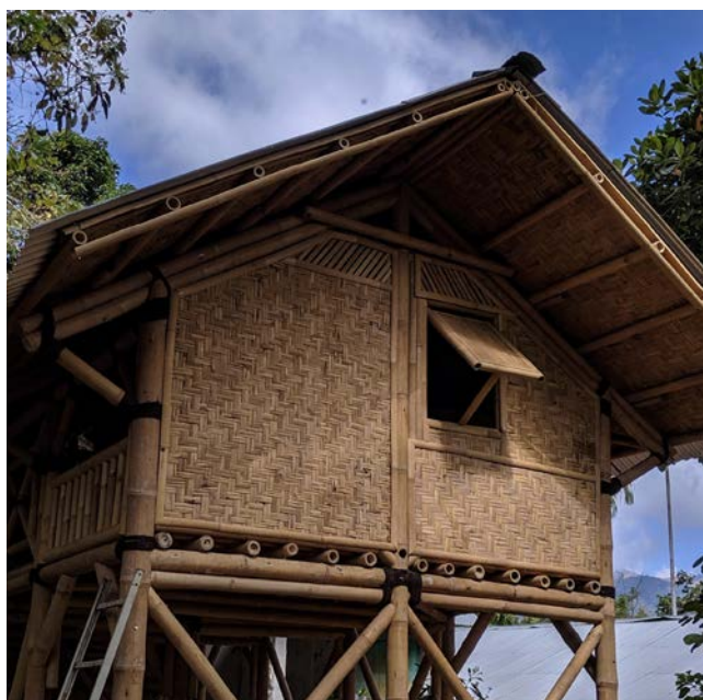
Dans le numéro 1 du volume 2 de notre revue, la société d'ingénierie des structures Ramboll a décrit son travail de construction de maisons en chaumes de bambou résistantes aux séismes. Crédit : Ramboll Royaume-Uni
