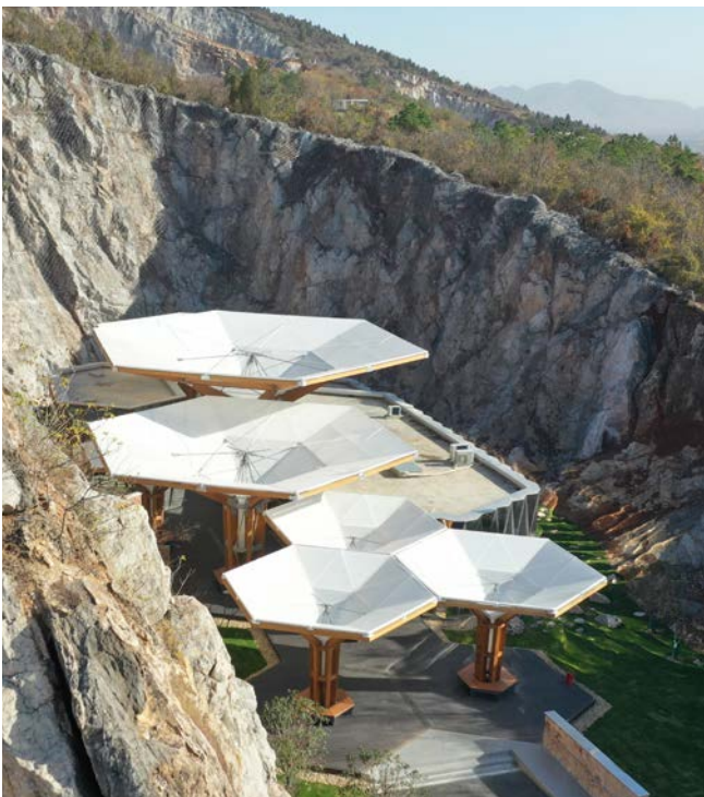
Détails de la structure de bambou lamellé-collé du centre d'accueil des visiteurs du camp de Tangshan, qui est situé sur un ancien site minier. Le plus grand toit « champignon » en bambou a un diamètre de 19 mètres. Crédit : Timeraw Studio
