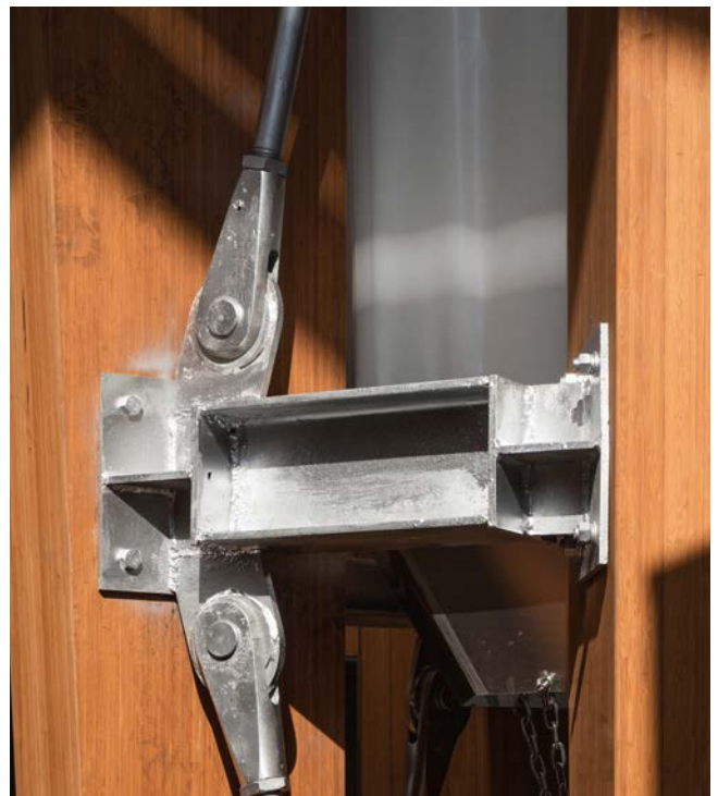
Détails de la structure de bambou lamellé-collé du centre d'accueil des visiteurs du camp de Tangshan, qui est situé sur un ancien site minier. Le plus grand toit « champignon » en bambou a un diamètre de 19 mètres. Crédit : Timeraw Studio
