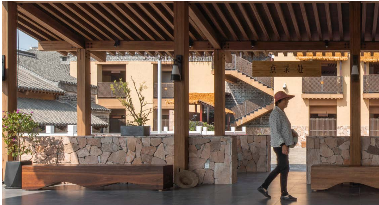
La structure en lamellé-collé de bambou dans la cour n° 4 du village de Lixiang est un espace partagé par les villageois et les touristes. Crédit : Timeraw Studio
