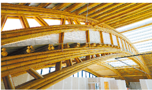
“竹之眼”展馆以创新科技构筑圆竹拱结构 吴君琦摄
