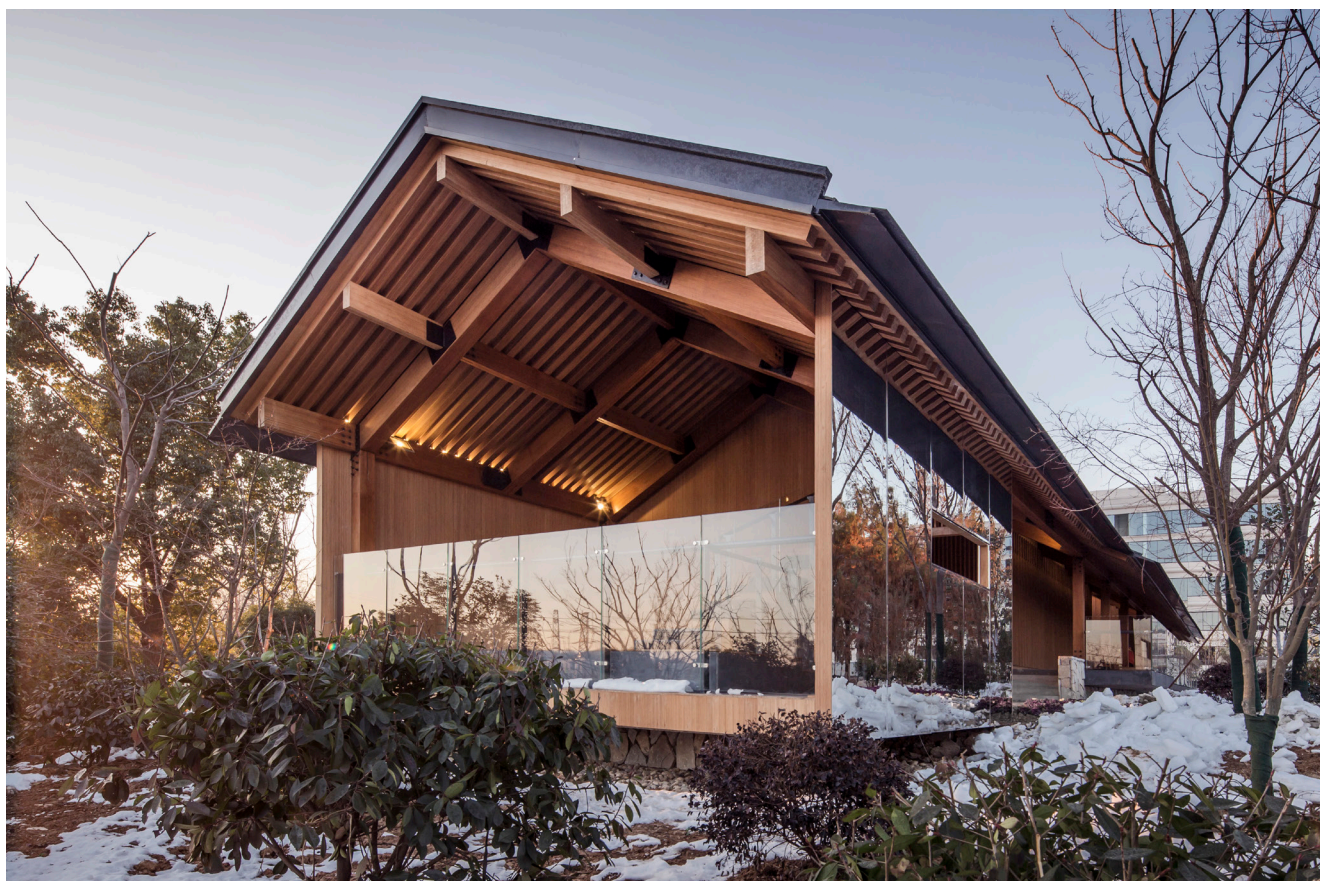
Des normes comme l'ISO 22156:2021 devraient ouvrir la voie à davantage de constructions comme les toilettes de Gallery Bridge, une structure en bambou créée par ATA Studio à Nanjing en Chine, et présentée dans le numéro de décembre 2021 du magazine Nouvelles du bambou et du rotin de l'INBAR. Crédit : Timeraw Studio
