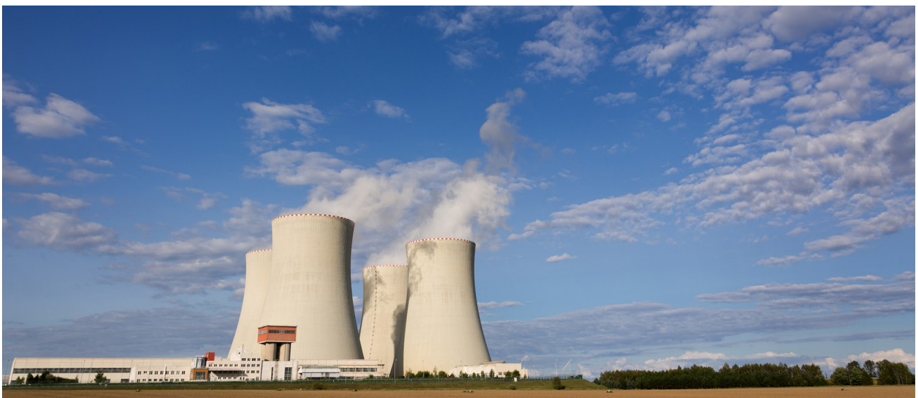
En las últimas décadas, las torres de enfriamiento de las plantas de energía han utilizado casi exclusivamente empaques de rejilla de PVC.
