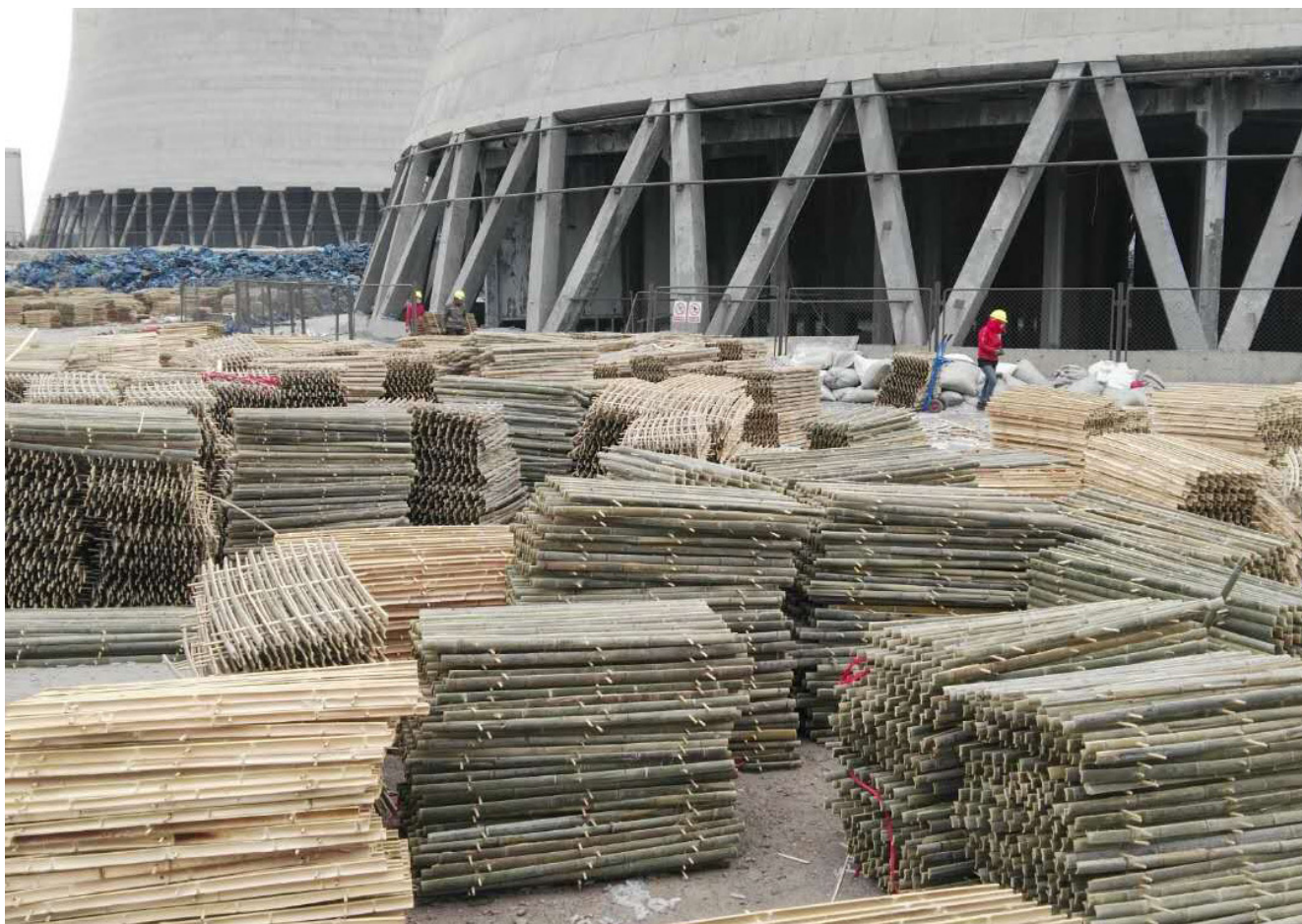
Instalación de empaque de rejilla de bambú en la planta de energía de Dongfeng, una de las 80 empresas en China que utilizan este equipo. Crédito: Ma Xinxin et al.
