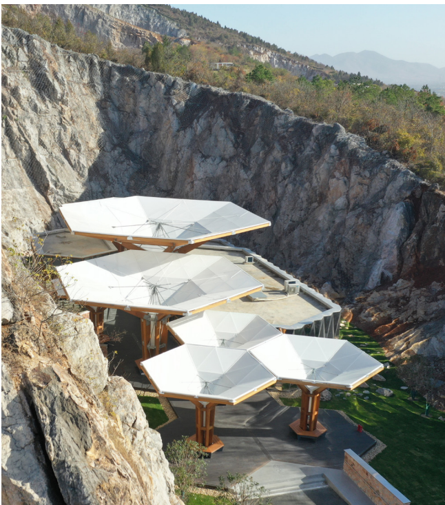
Detalles de la estructura del Centro Turístico Tangshan Pit Camp, que está situado en un antiguo sitio minero. El techo de bambú con forma de hongo más grande tiene un diámetro de 19 metros. Crédito: Estudio Timerav.
