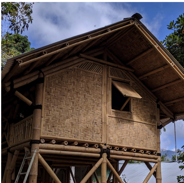
En BRU Volumen 2 Número 1, la empresa de ingeniería estructural Ramboll describió su trabajo de construcción de casas resistentes a los terremotos con bambú rollizo. Crédito: Ramboll Reino Unido.
