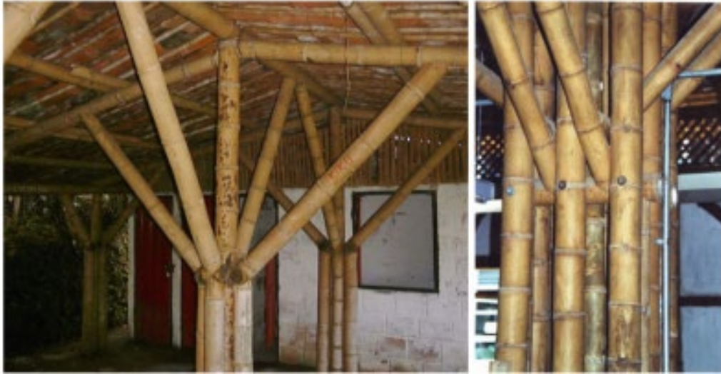
Figure 12: Constructions de toits : constituées de plusieurs chaumes avec des connecteurs intégrés
