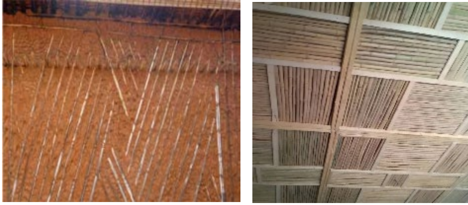
Figure 36: Utilisation du bambou dans le secteur de la construction. Gauche : Mûr en bambou et terre, Oku, Nord-Ouest ; Droite : plafond en bambou à Dschang, ouest Cameroun
