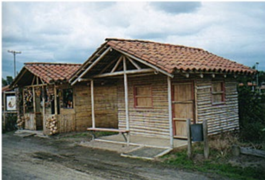
Figure 13: Kiosque en bambou
