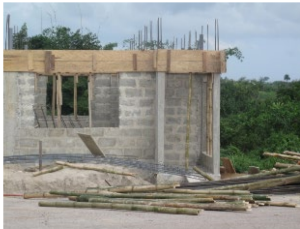
Figure 37 : Bambou comme support pour dalle à l'Ouest-Cameroun, Droite :
