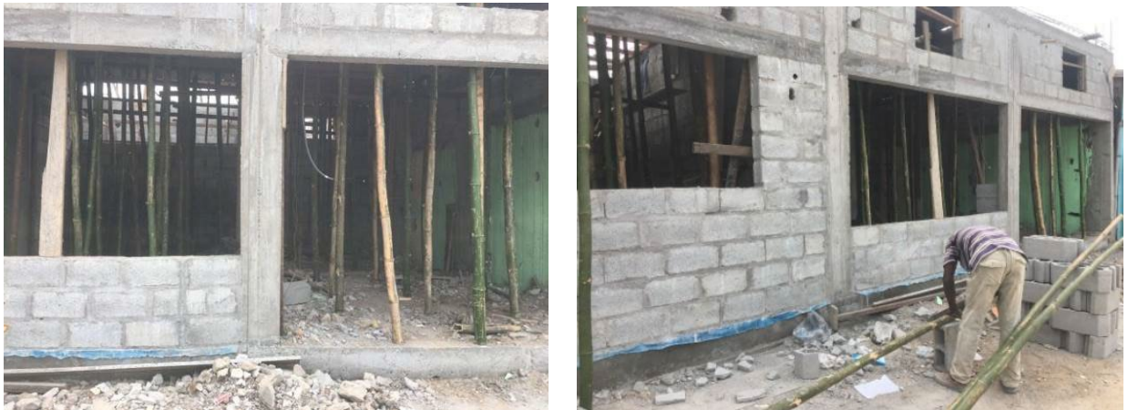
Photo 4. Utilisation de chaume de Bambou comme poteau de soutien pour la dalle
