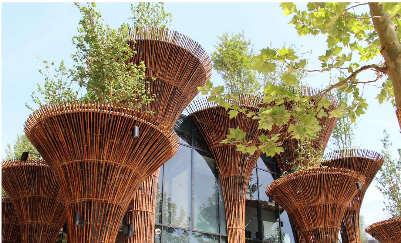
Conçu par Vo Trong Nghia Architects avec l'architecte associé Takashi Niwa, le remarquable pavillon du Vietnam à l'Expo de Milan de 2015 comportait des colonnes recouvertes d'un revêtement en bambou. Crédit : Fred Romero.
