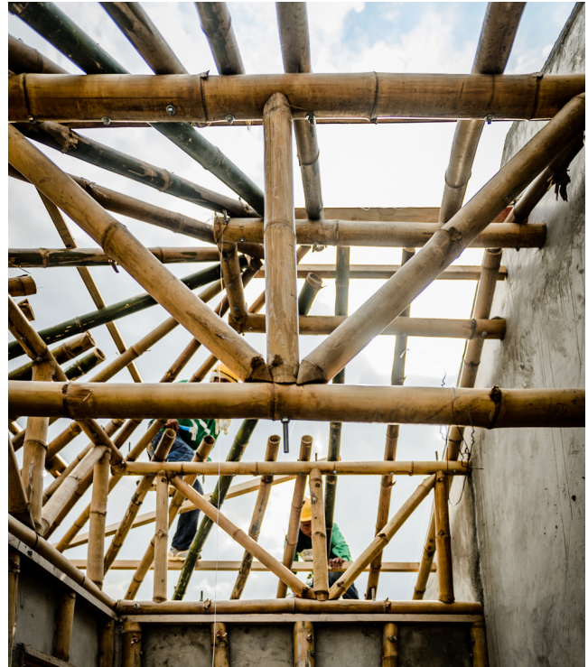
Une combinaison de mortier et de bambou est utilisée pour créer des structures légères et résilientes face aux catastrophes naturelles. Crédit : Base Bahay.
