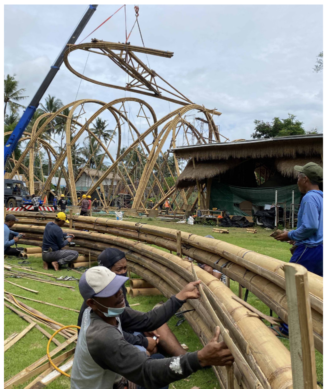
在巴厘岛绿色学校，起重机正在起吊“弧”结构的竹拱。
