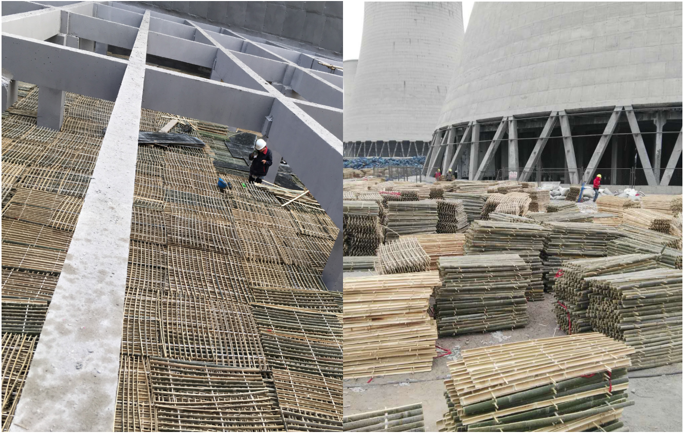
东风汽车热电厂工人正在安装竹格填料包，东风汽车热电厂是使用竹格填料的80家中国公司之一。供图：马欣欣等
