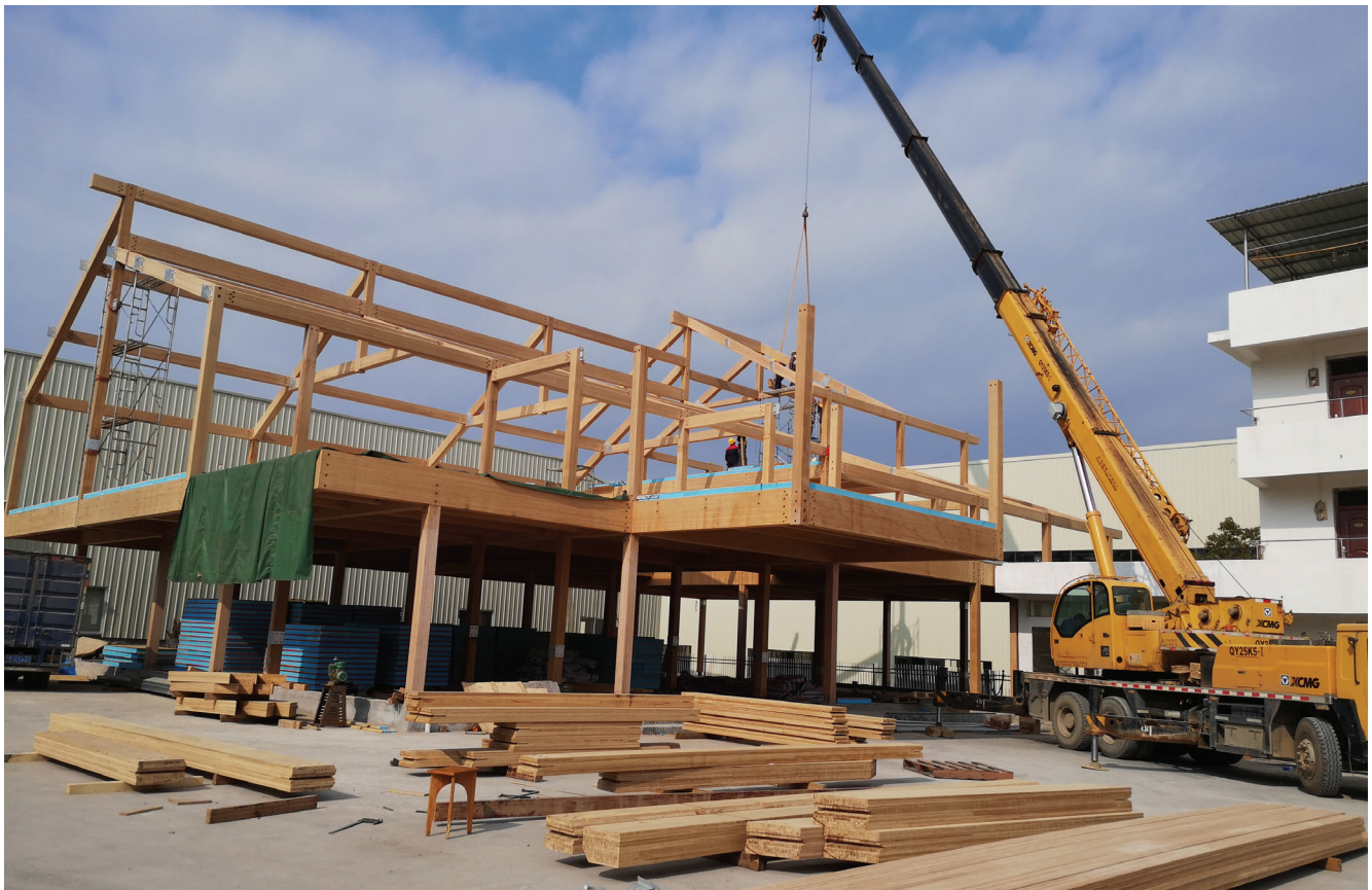
在中国，一座用胶合竹集成材建造的两层建筑正在施工中。竹子是中国数千年来传统建材，在新型建筑中的应用不断拓宽，耐久性能也日益提高。供图：赣州森泰竹木有限公司
