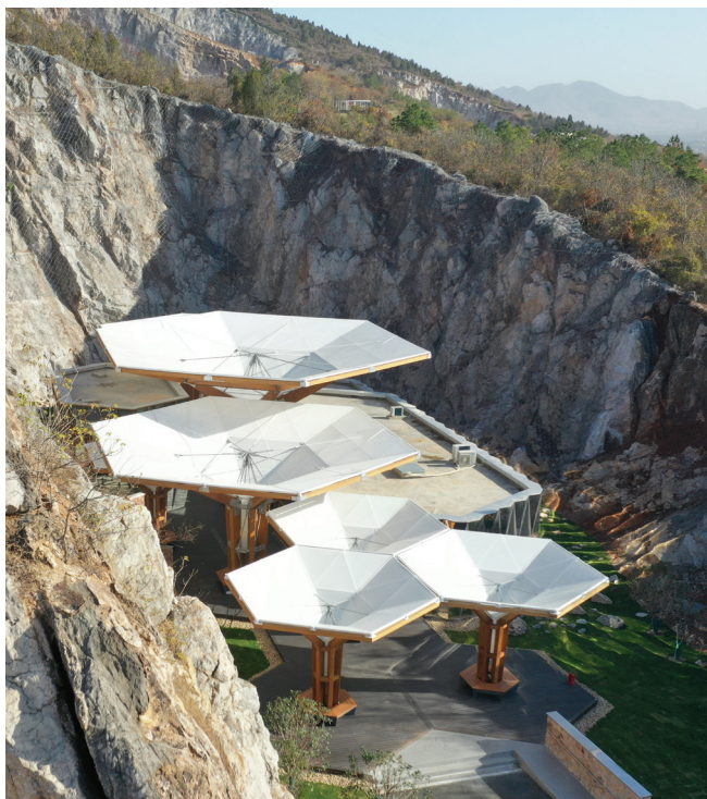
老矿区汤山矿坑游客中心的竹集成材结构。最大竹制“蘑菇”屋顶的直径长达19米。供图：Timeraw工作室
