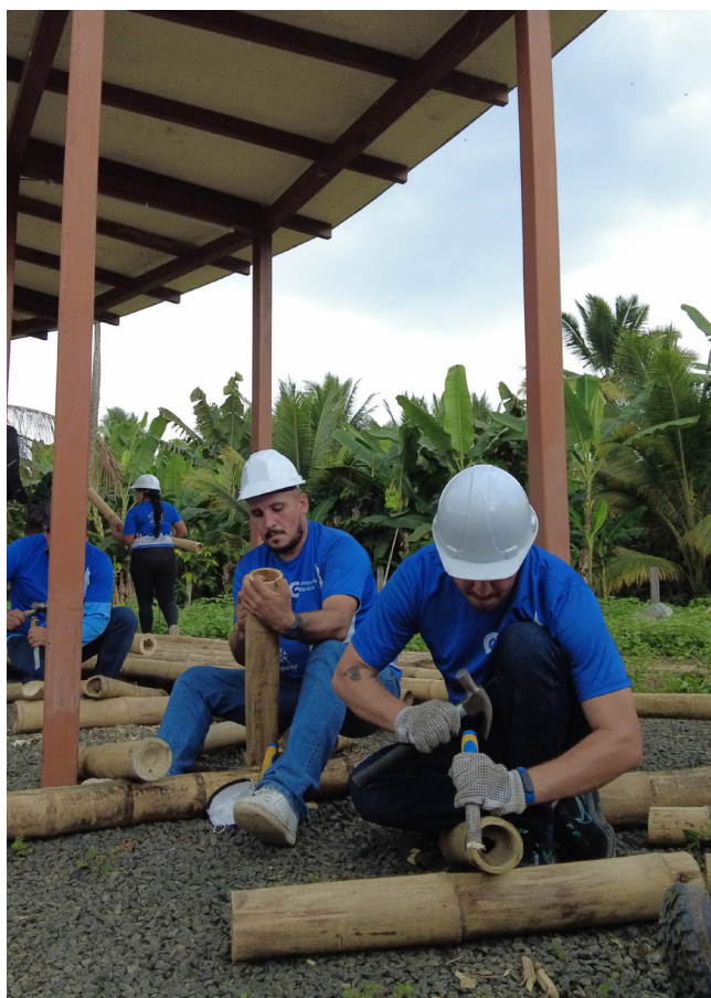
Estudiantes de la Escuela Taller Manabí aprenden de manera práctica sobre construcción con bambú. Crédito: INBAR.
