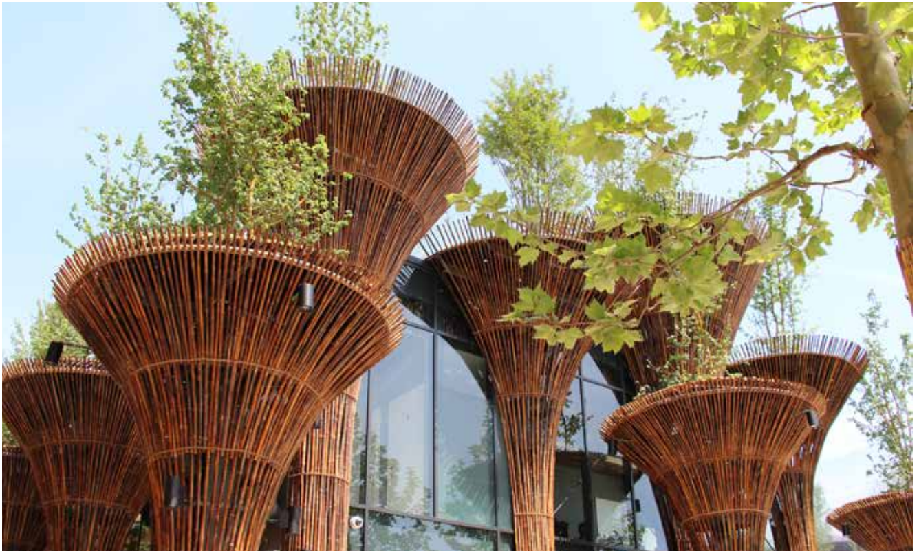
由武重义（Vo Trong Nghia）建筑事务所和建筑师丹羽隆志（Takashi Niwa）设计的2015年米兰世博会越南馆，场馆立柱以竹材包裹，尽显令人惊艳的自然之美。供图：弗雷德·罗梅罗（Fred Romero）。
