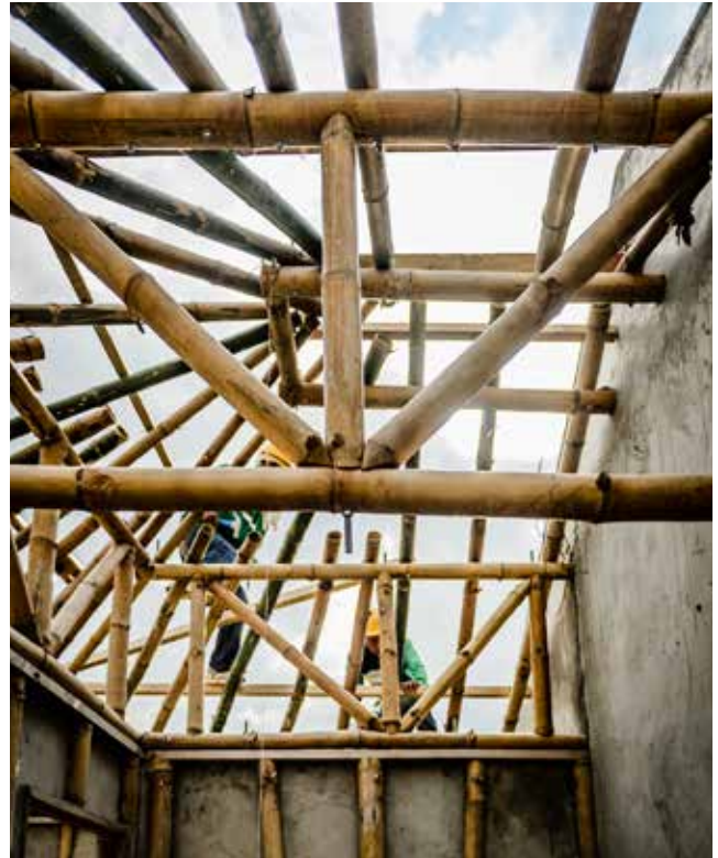
利用水泥砂浆与竹材的混合使用打造出轻质抗灾的住房结构。
