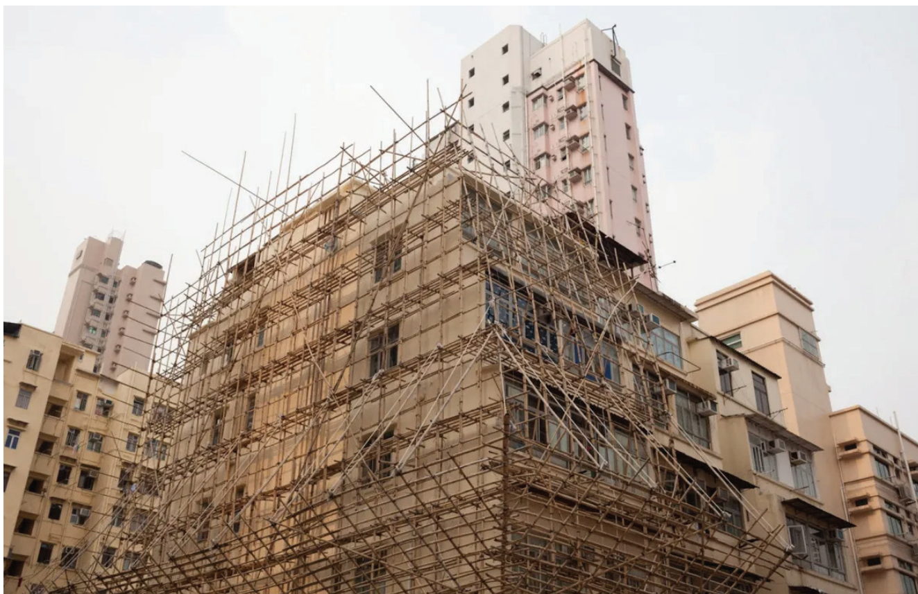
香港一座建筑周围搭建的竹脚手架。供图：iStock
