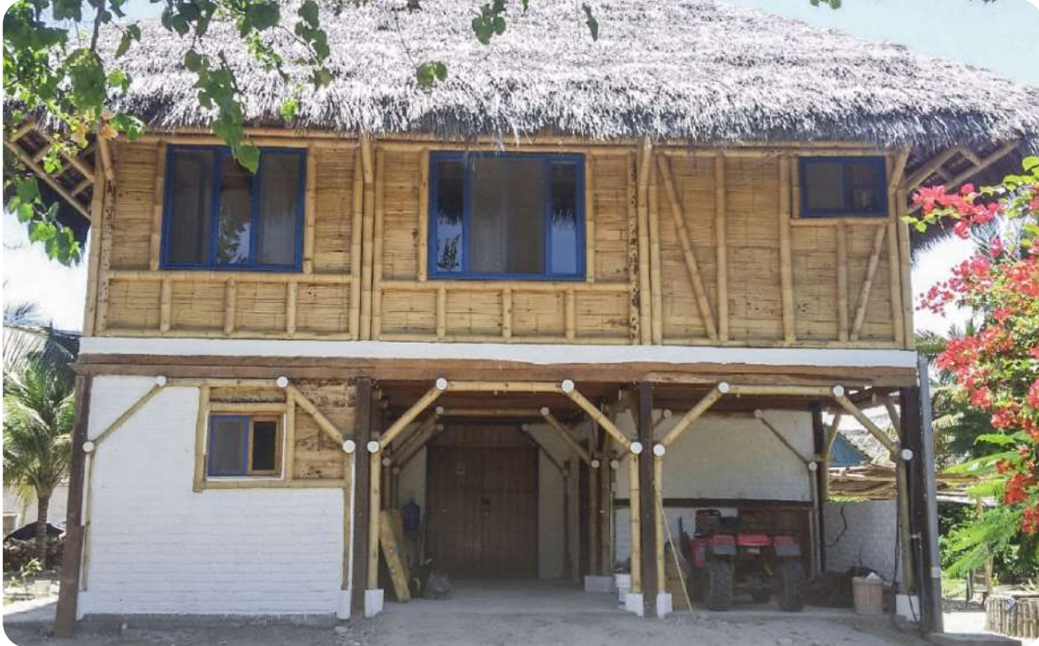
Ilustración 4. Vista de parales de bambú GaK en fachada de vivienda. Fuente: Manabí Bambú, 2020.
