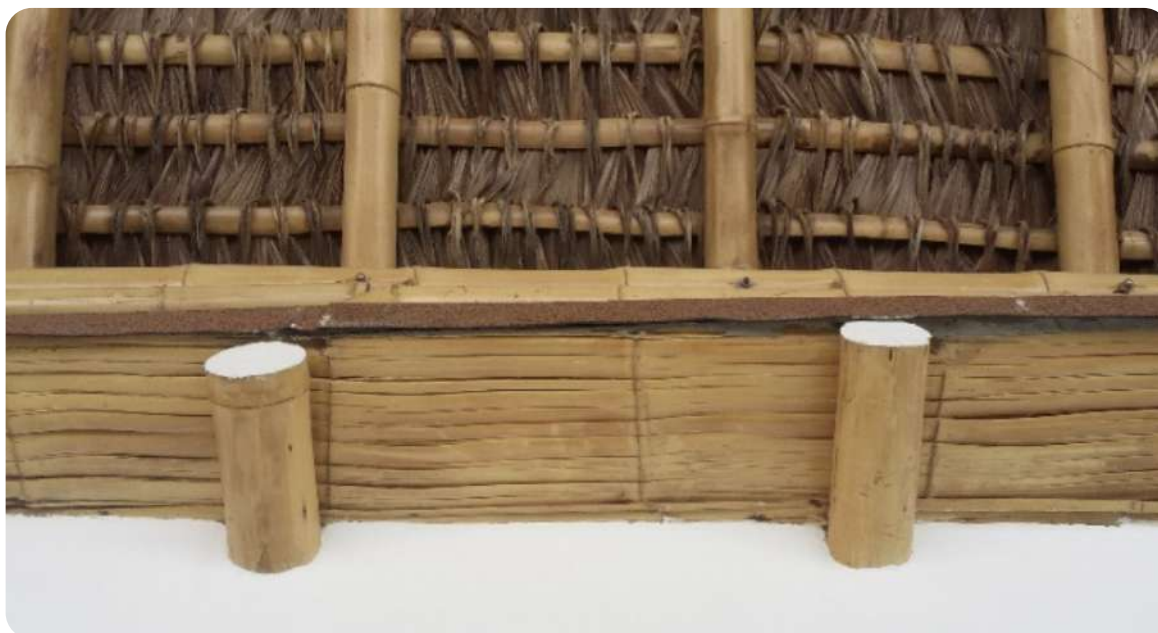
Ilustración 12. Sellado de canutos. Fuente: Manabí Bambú, 2020.
