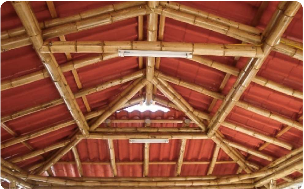
Ilustración 2. Vista del entramado de bambú GaK en cuerdas de cubierta. Fuente: Manabí Bambú, 2020.
