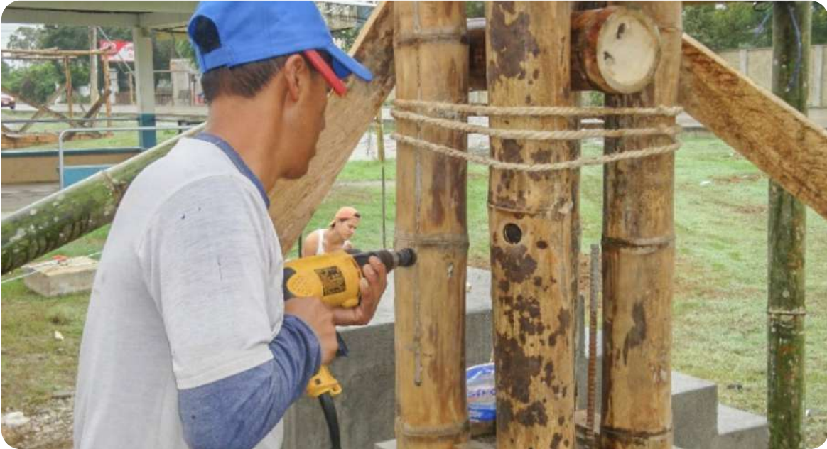
Ilustración 11. Inyección de mortero en canutos. Fuente: Manabí Bambú, 2020.
