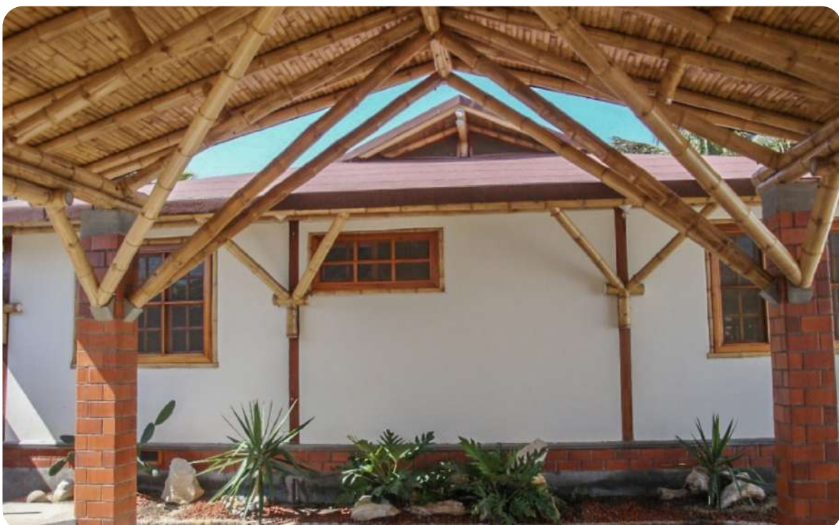
Ilustración 10. Vista de contretes o diagonales de bambú GaK. Fuente: Manabí Bambú, 2020.
