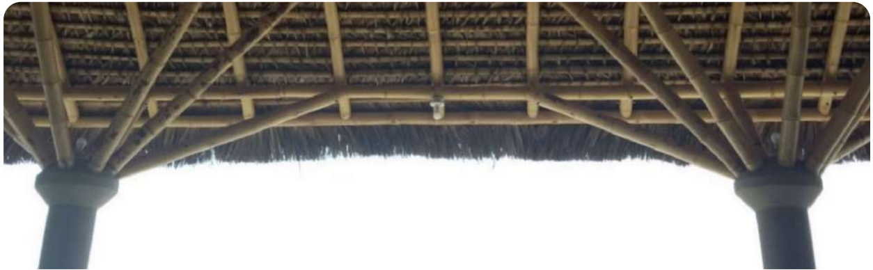
Ilustración 6 . Vista interior de vigas simples de bambú Gak. Fuente: Manabí Bambú, 2020.
