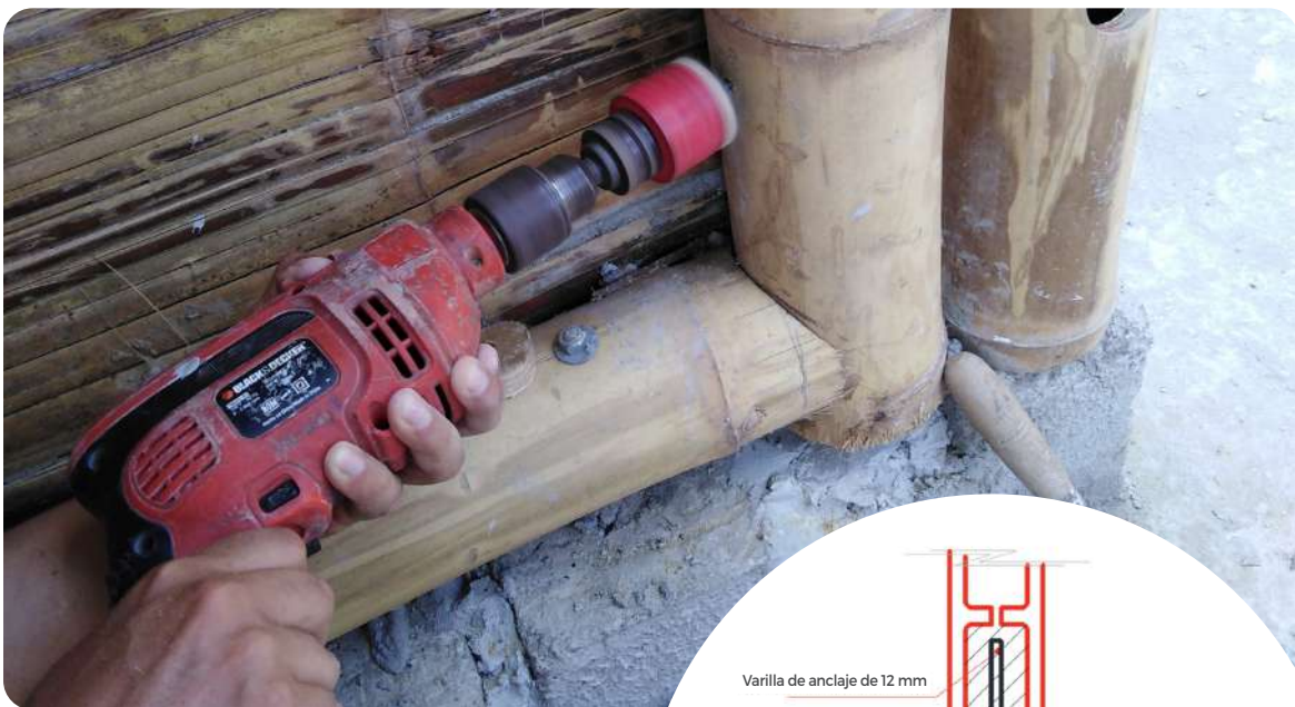
inyección de mortero en nudos críticos y anclajes
