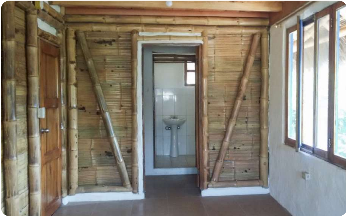
Ilustración 9. Vista de contretes o diagonales de bambú GaK. Fuente: Manabí Bambú, 2020.
