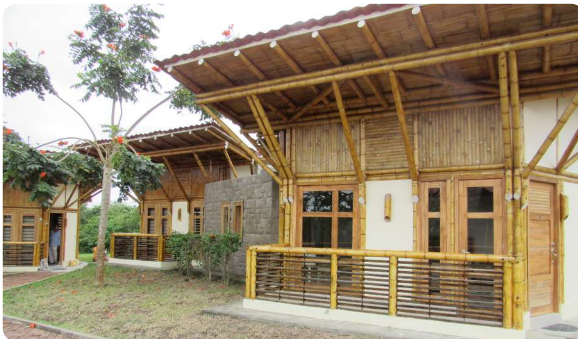
Vigas dobles de bambú GaK
