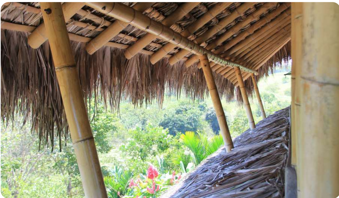
Viga simple de bambú Gak.
