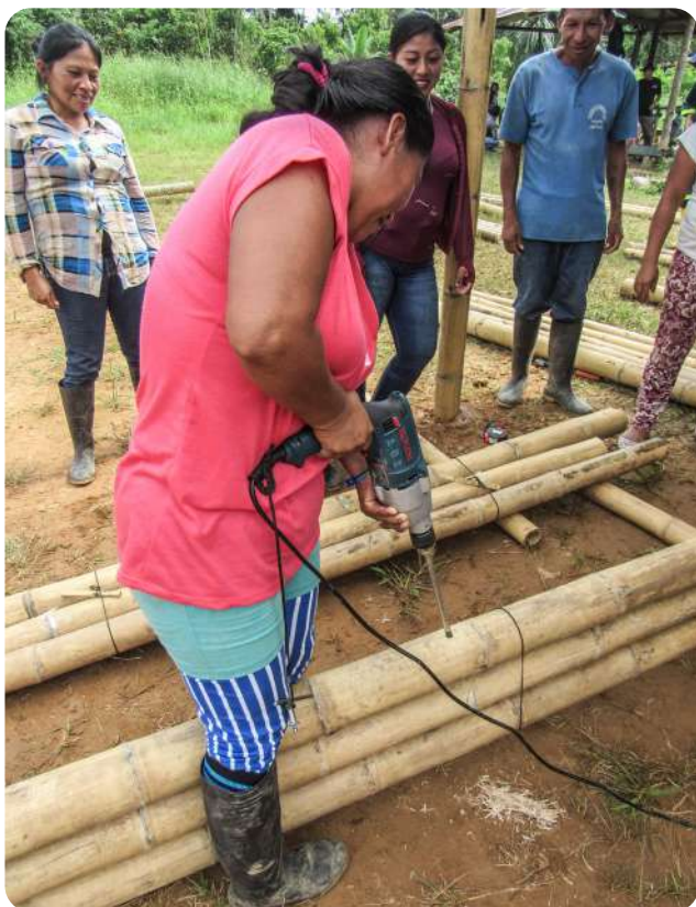
Armado de columna en el piso
