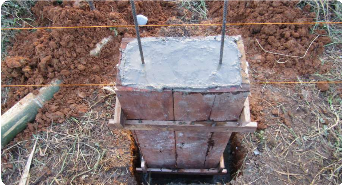
Columna de hormigón armado, con varillas de anclaje No.12
