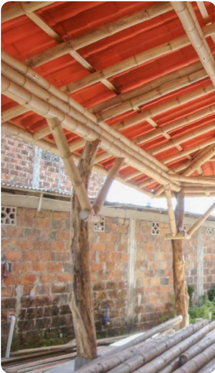
Ilustración 8. Vigas triples con Bambú GaK. Fuente: Manabí Bambú, 2020.
