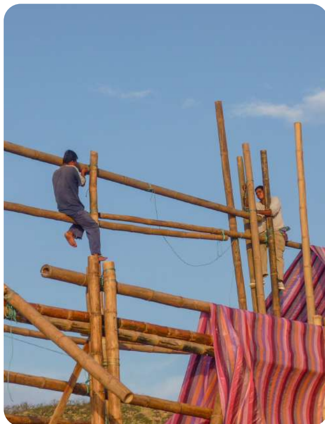
Trabajos en altura
