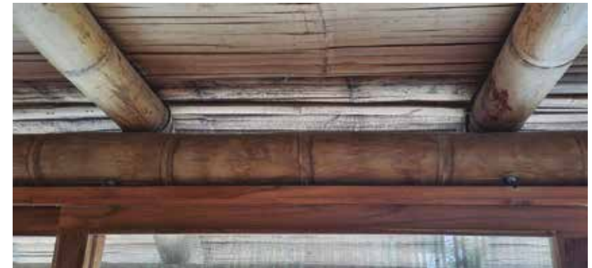
Foto 30. Espacio entre las vigas de techo.
