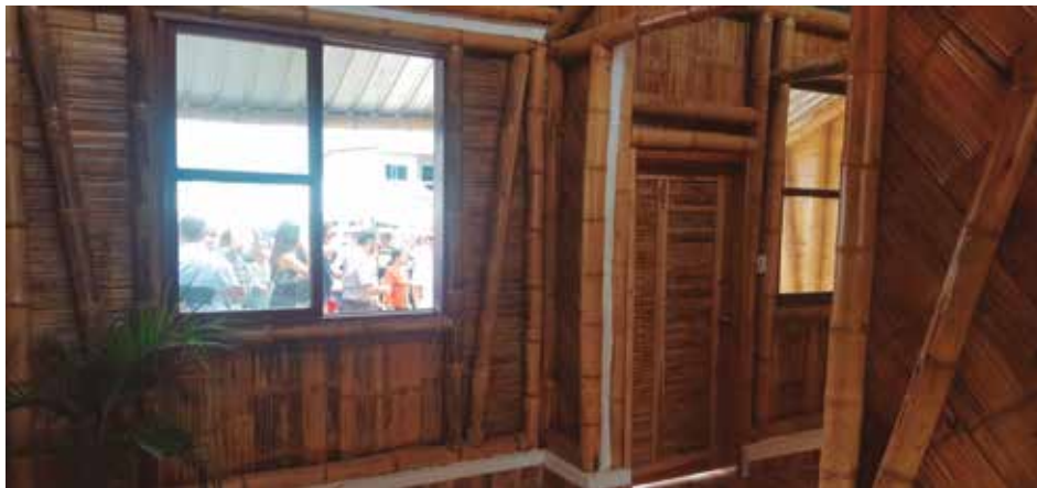
Foto 17. Culmo en posición diagonal a cada extremo del panel o pared.
