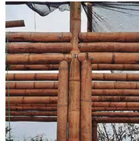
Foto 16. Uniones viga principal y columnas.
