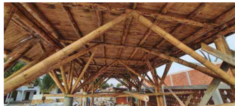
Foto 25. Cielo raso de caña picada.
