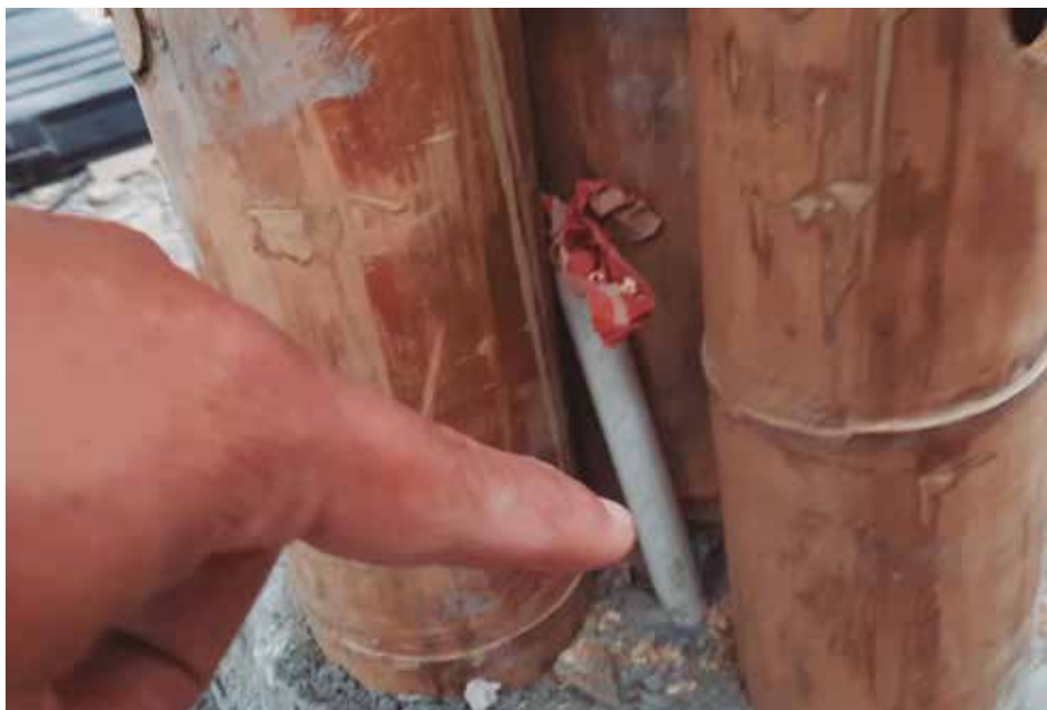
Foto 12. Instalación de tuberías en cimentación.
