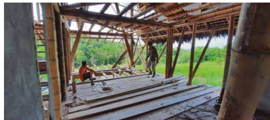
Foto 20. Vigas de piso.
