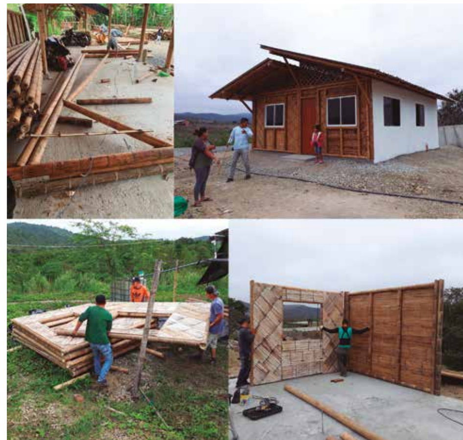
Foto 2. Columna y cercha prefabricada, paneles prefabricados.
