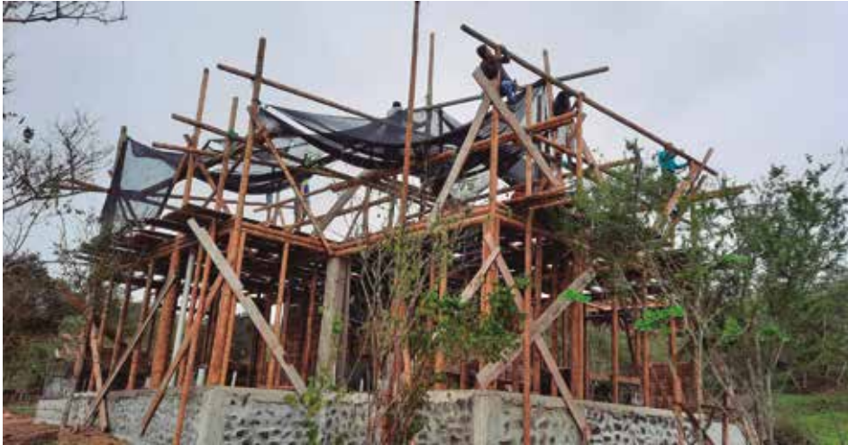
Foto 15. Plomeadas de columnas 2 niveles.
