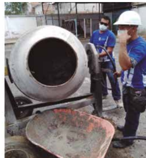
Foto 13. Mezcla de hormigón.
