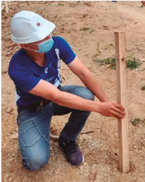
Foto 4. Estaca de trazado.
