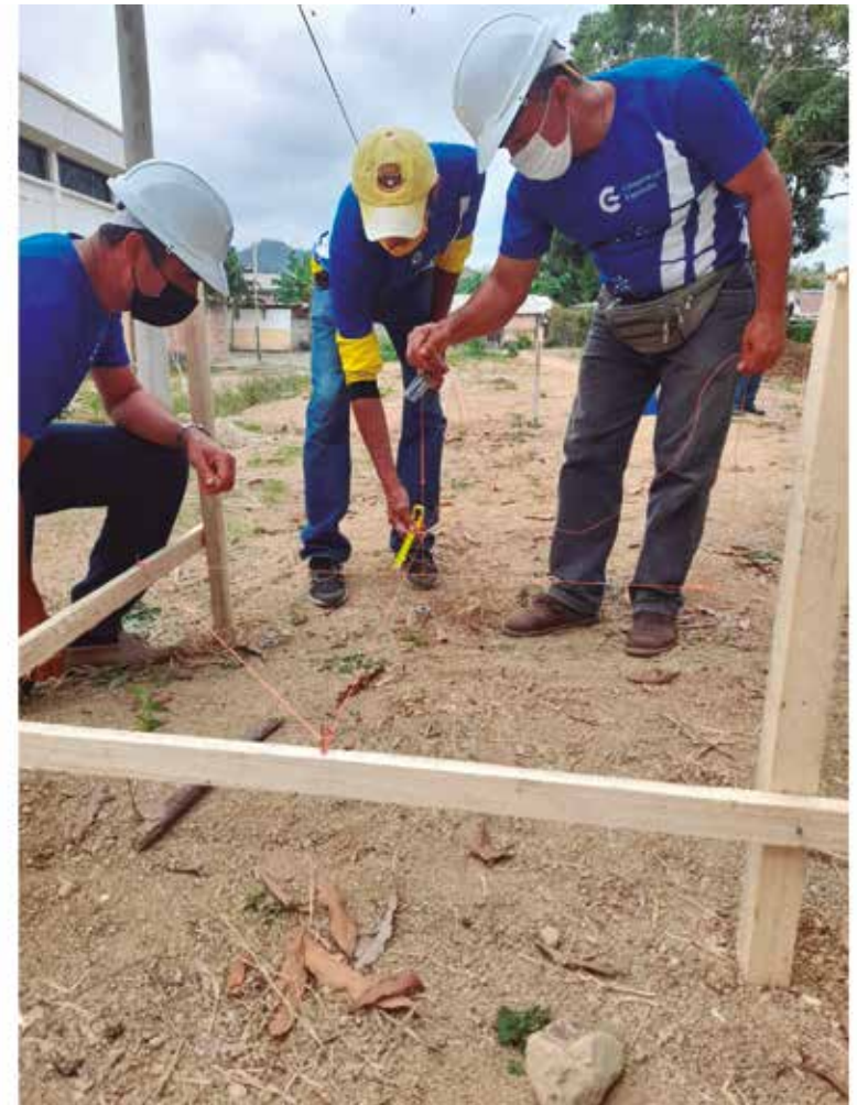
Foto 6. Plomada en replanteo.
