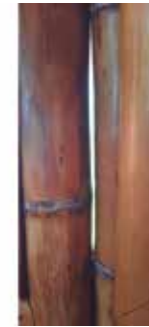
Foto 29. Espacio entre canutos.
