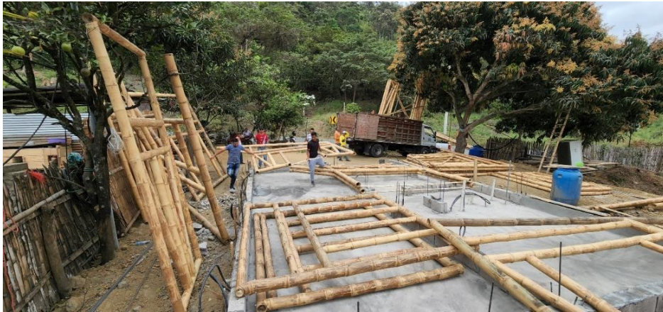
Figura 4. Fotografía de descarga de cerchas y pórticos prefabricados
