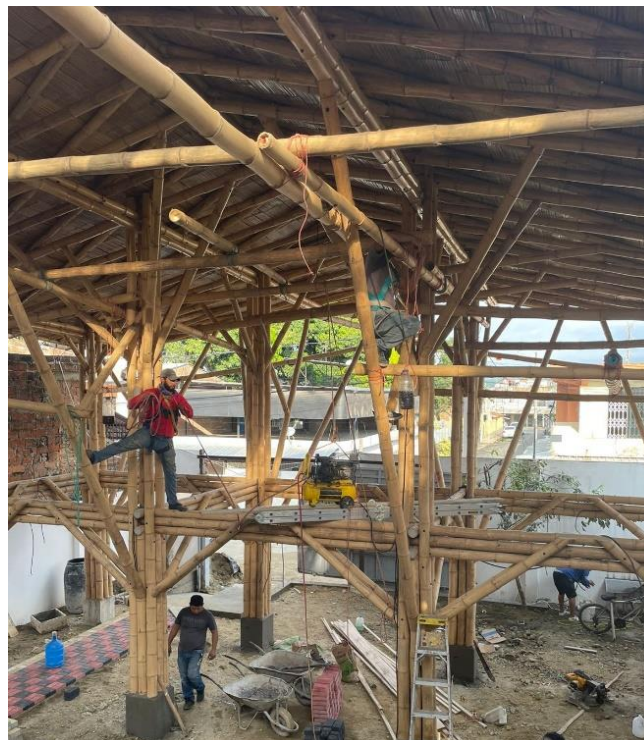
Figura 15. Fotografía de la construcción
