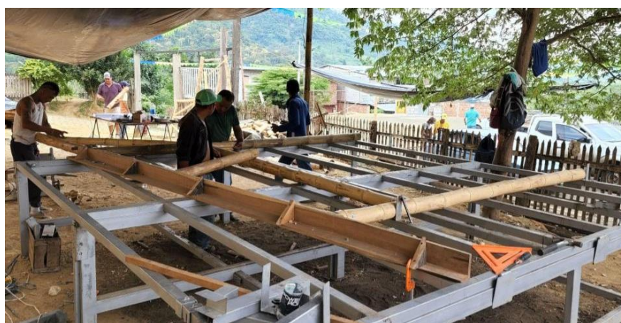
Figura 3. Fotografía de armado de paneles y pórticos
