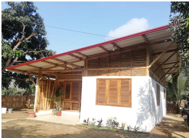
Figura 1. Fotografía vivienda prototipo terminada
