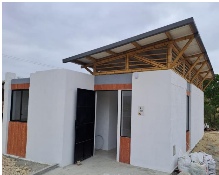
Figura 7. Fotografía tipología de vivienda terminada
