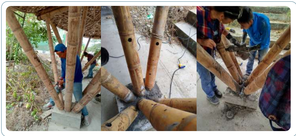
Ilustración 9: Ejemplo de llenado de canutos con mortero, las perforaciones siempre deben estar cerca del nudo.
