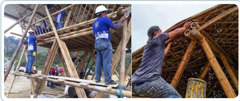
Ilustración 11: Tapones de mezcla (con clavitos, grapas) en extremidades de culmos rectos.
