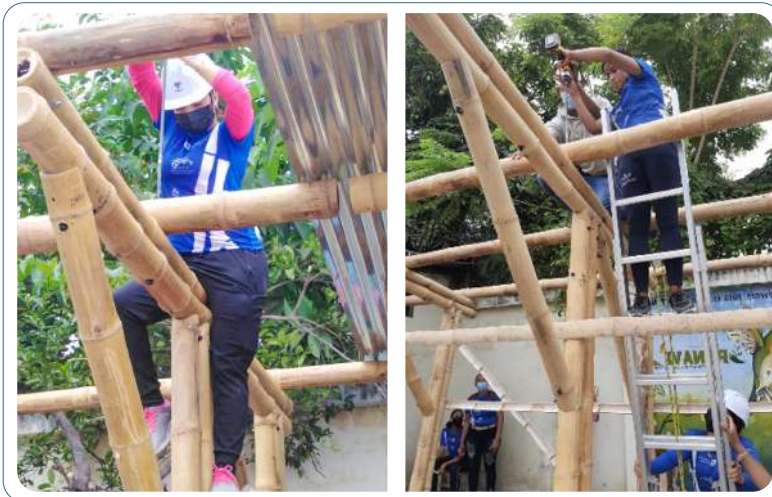
Ilustración 12: : Todos los pernos tienen que pasar cerca de un nudo.
