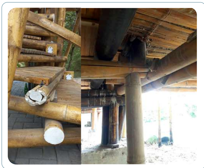
Ilustración 10: Ejemplos de aplastamiento del culmo.
