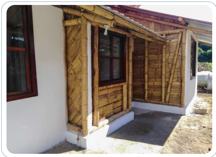
Ilustraci3n 5 : Protecci3n por dise1o. Los elementos de GaK son protegido de la humedad, sol y lluvia.
