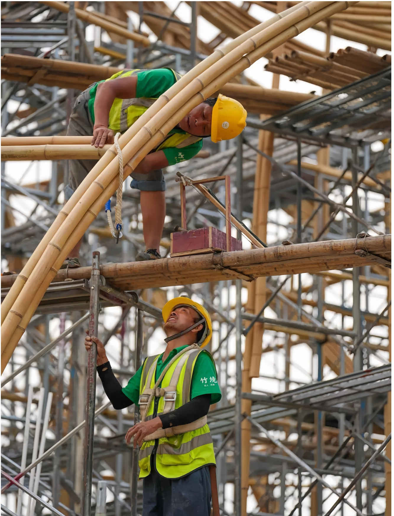
Trabajadores de la construcción en Zhujing construyendo un edificio de bambú. Crédito: Hainan Daily, Zhujing.
