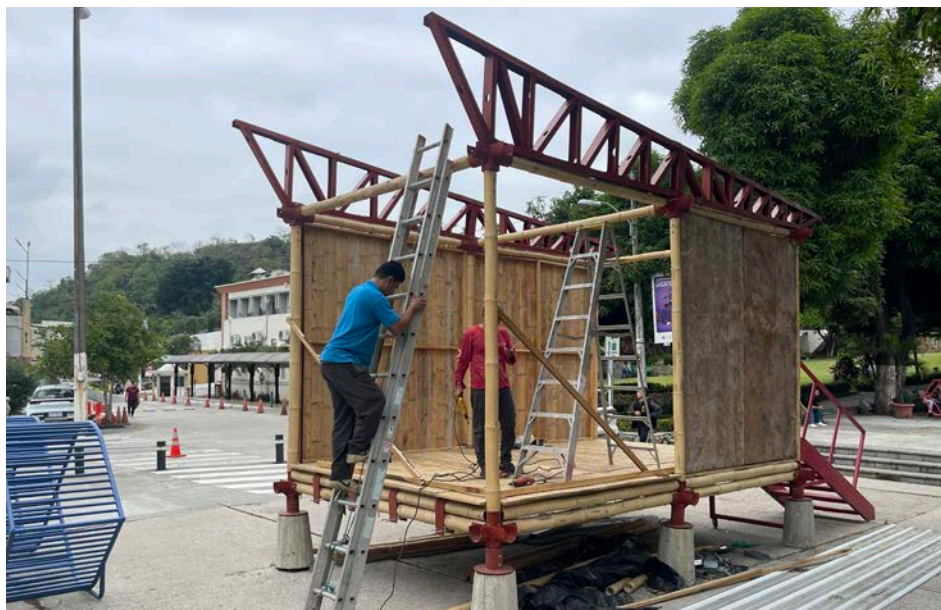
Vista de la estructura en conjunto.
