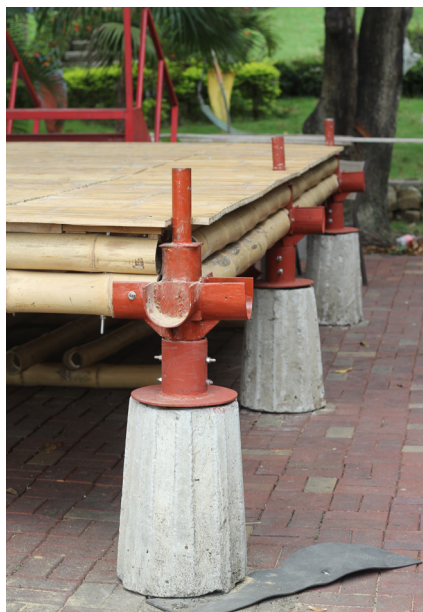
Piso de paneles de caña completado.
