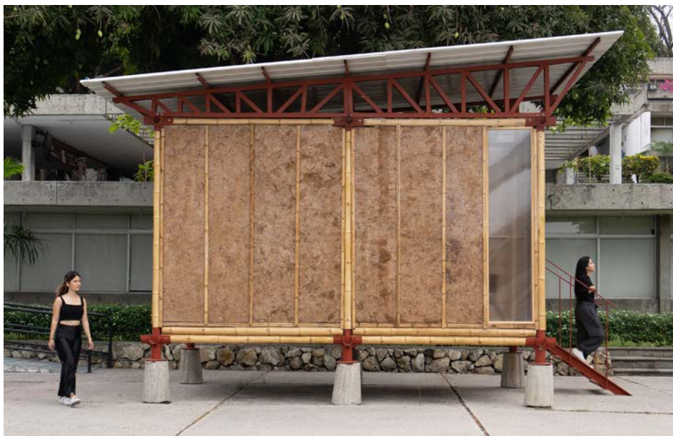
Alzado lateral de la vivienda de emergencia.
