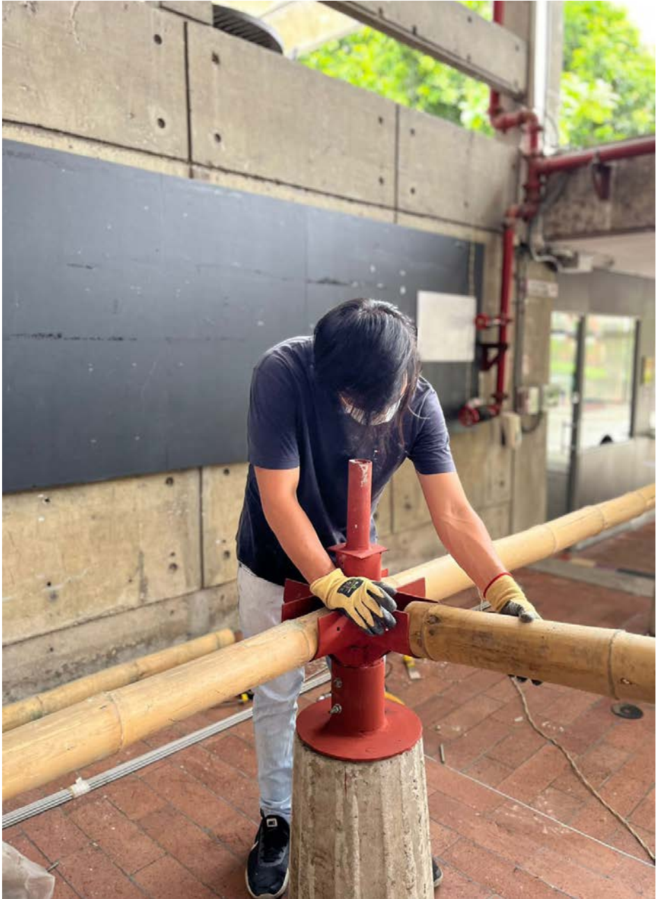
Ajuste y ensamblaje preciso de la caña al detalle constructivo completado.
