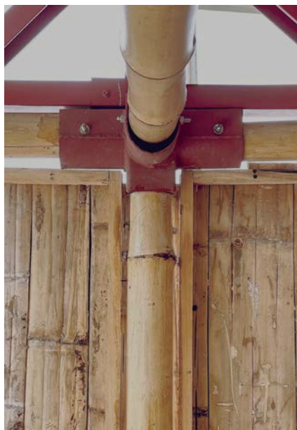
Detalle constructivo desde el interior.
