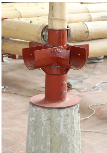
Conexión finalizada entre la base y las cañas.
