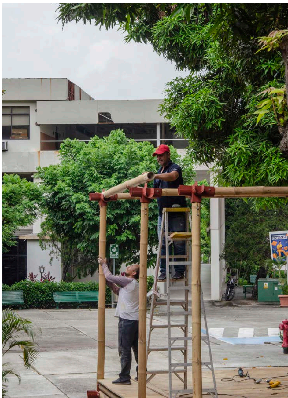
Incorporación de vigas.
