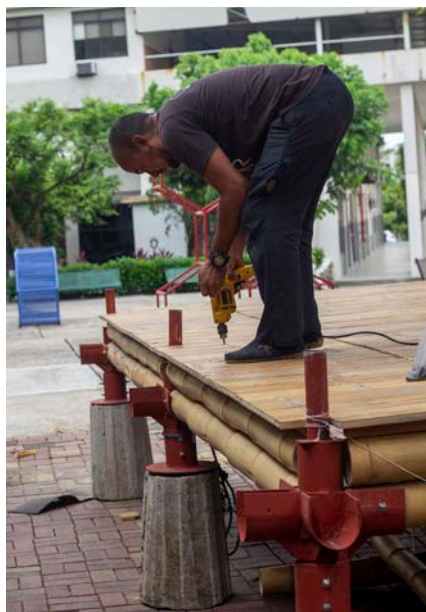
Integración de paneles de cañas.
