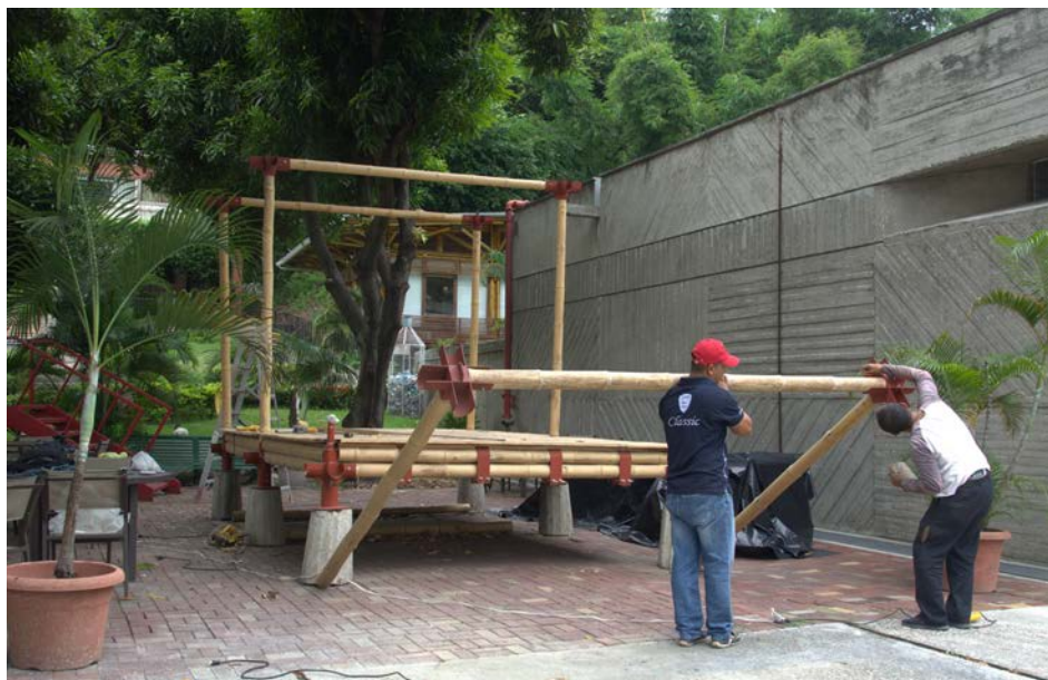
Elevación de columnas.
