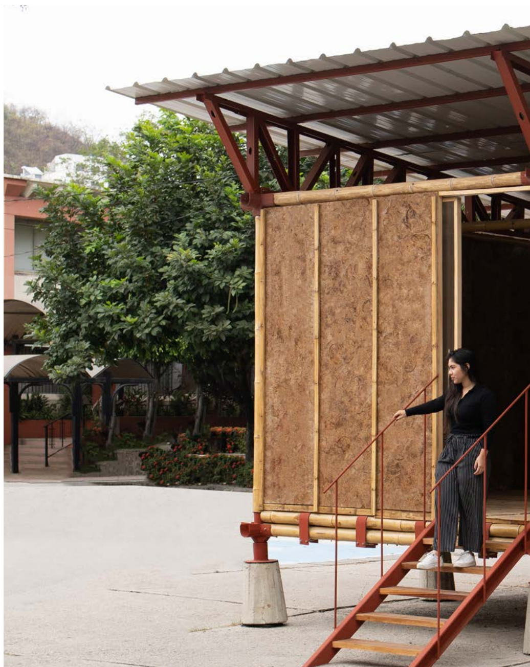
Vista de acceso al refugio destacando el diseño elevado y la estructura de bambú.
