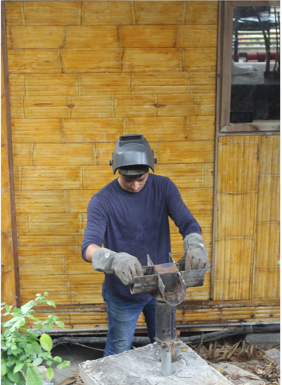
Proceso de ensamblaje de piezas mediante técnicas de soldadura.
