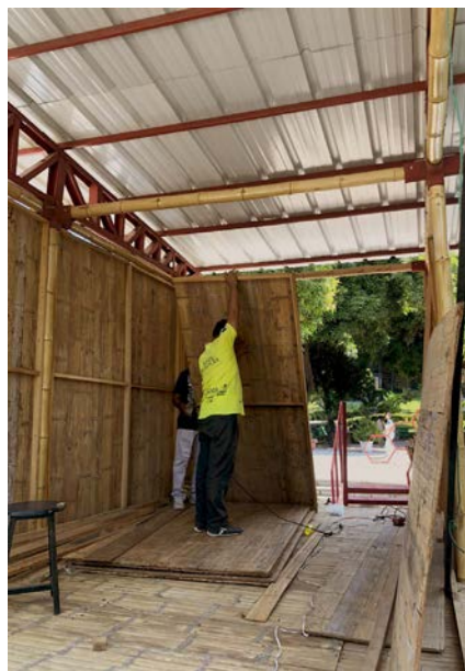
Muros construidos por paneles de caña.
