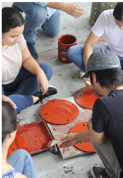
Recubrimiento anticorrosivo en componentes.
