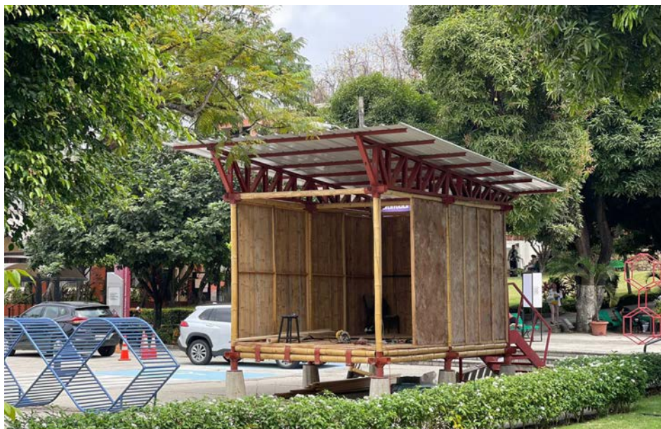
Vista exterior del refugio de emergencia.
