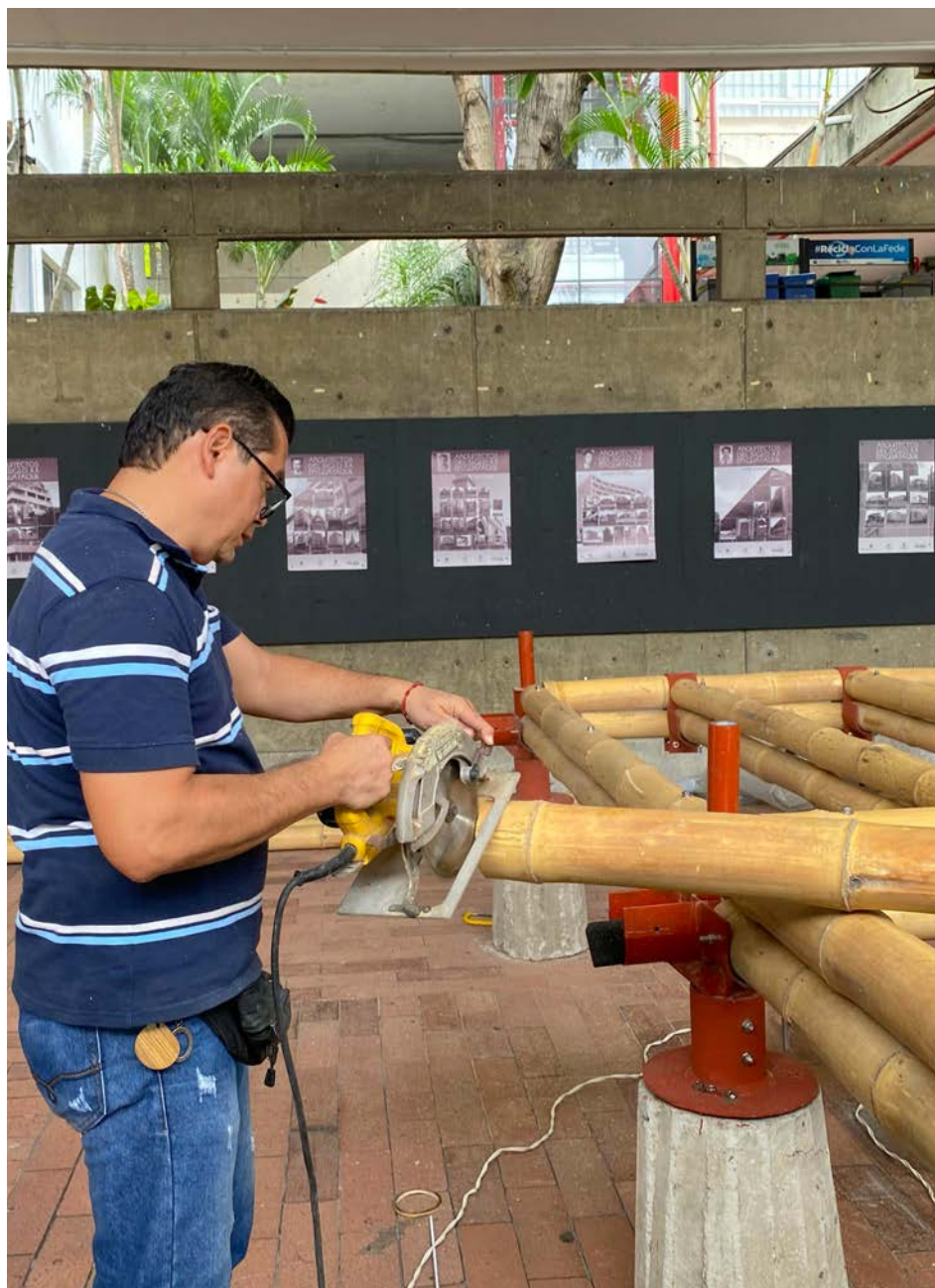
Cortes detallados para el ajuste preciso de la caña con el componente estructural.
