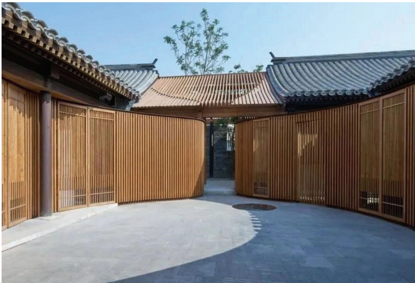
竹质复合材料墙体。供图：冯鹏飞
