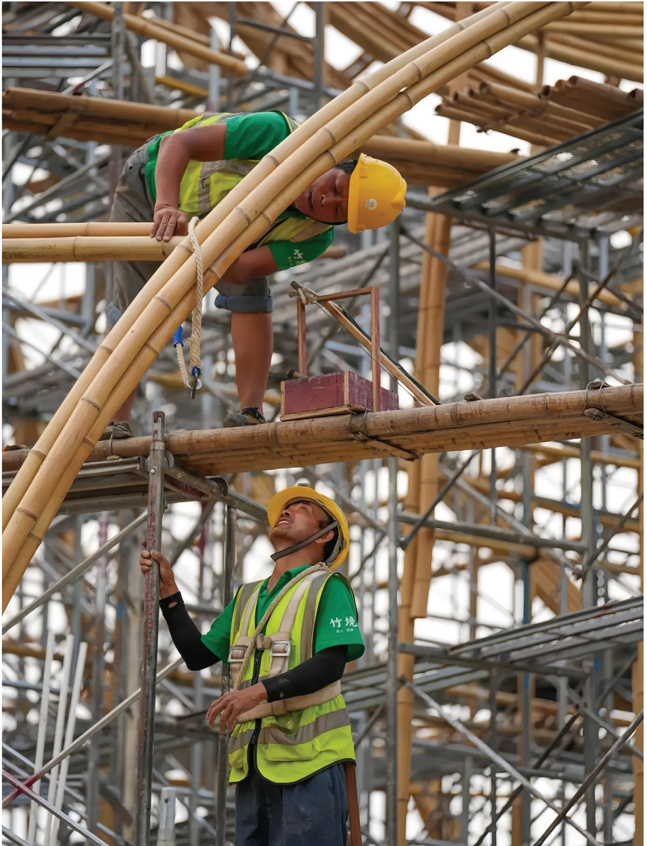
竹境的工人在建造大型竹建筑。供图：海南日报、竹境
