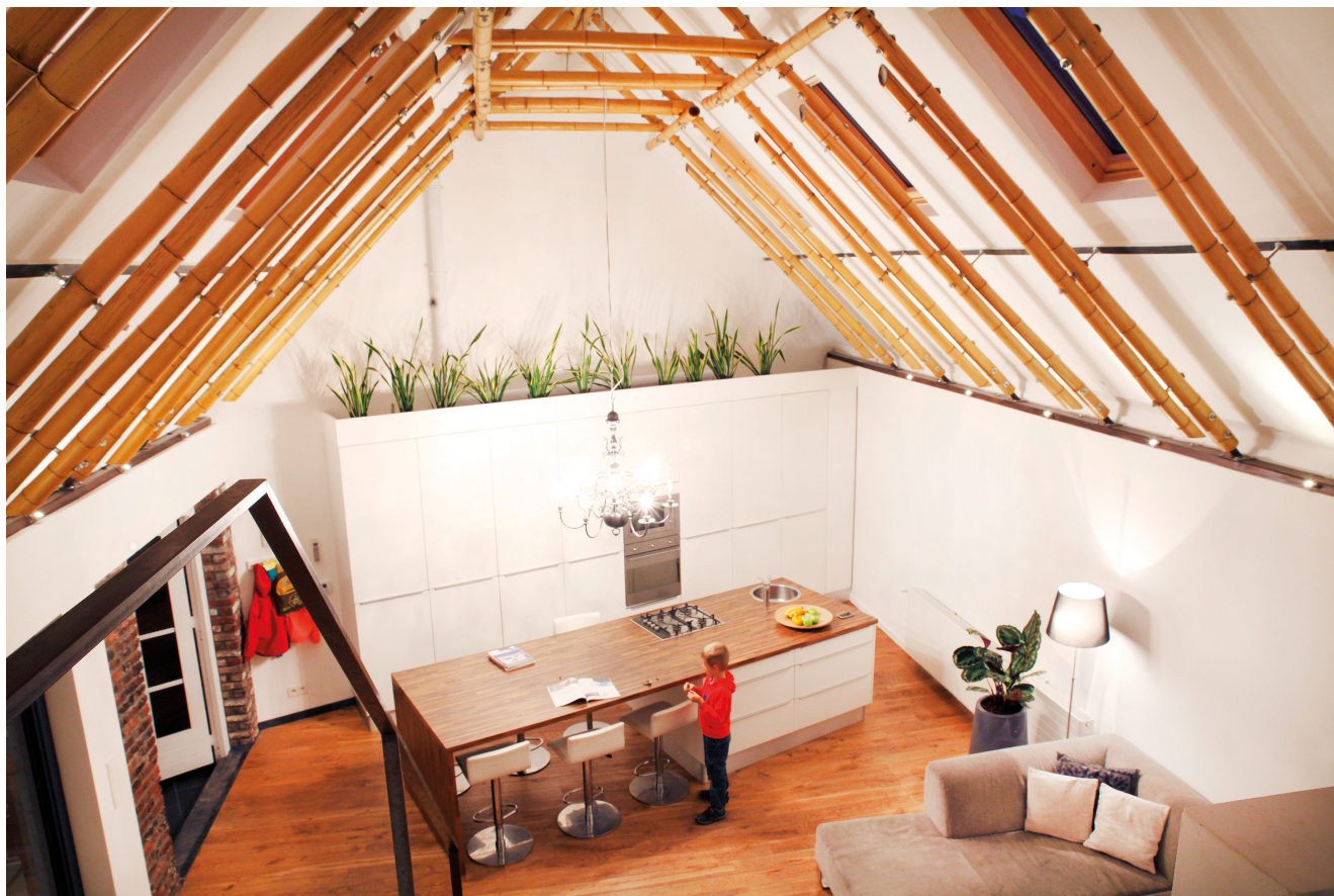
Uno de los pocos ejemplos del uso estructural de la caña de bambú en una estructura permanente en Europa. Esta vivienda privada fue diseñada por el arquitecto Sven Mouton en Gante, Bélgica. Crédito: Sven Mouton
