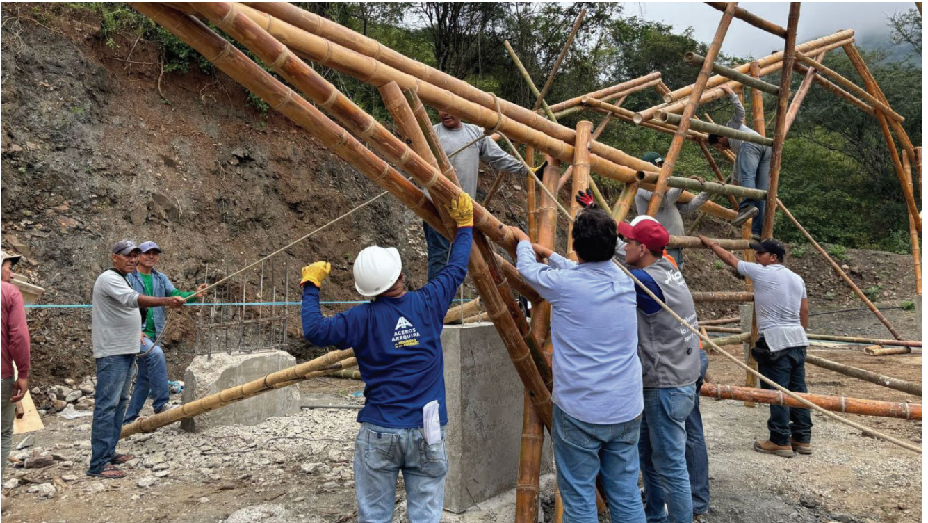
当地建筑工人接受了竹材建筑技术的培训，并协助在秘鲁皮乌拉建造了一座煤砖厂。
