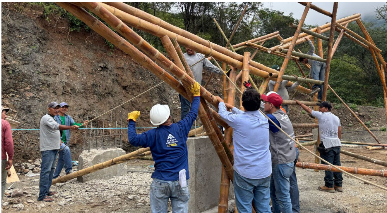
Constructores locales fueron capacitados en técnicas de construcción con bambú, ayudando a instalar una planta de briquetas en Piura, Perú.
