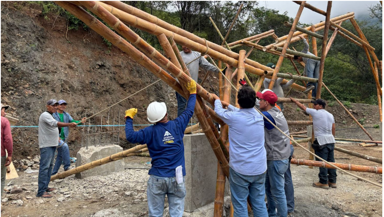
Des ouvriers locaux ont été formés aux techniques de construction en bambou, participant à l'édification d'une fabrique de briquettes à Piura, au Pérou.
