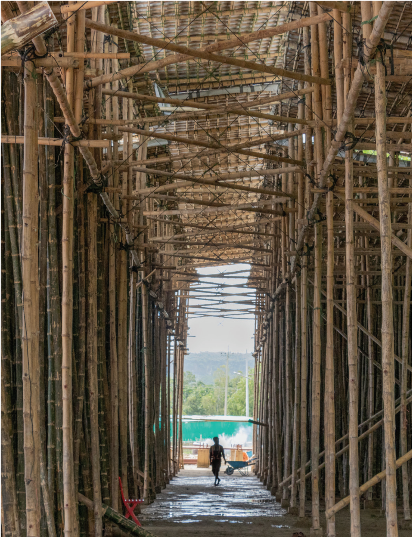
Instalaciones para tratamiento del bambú aportando soluciones duraderas a los refugiados rohingya. Crédito: Nate Webb/IOM
